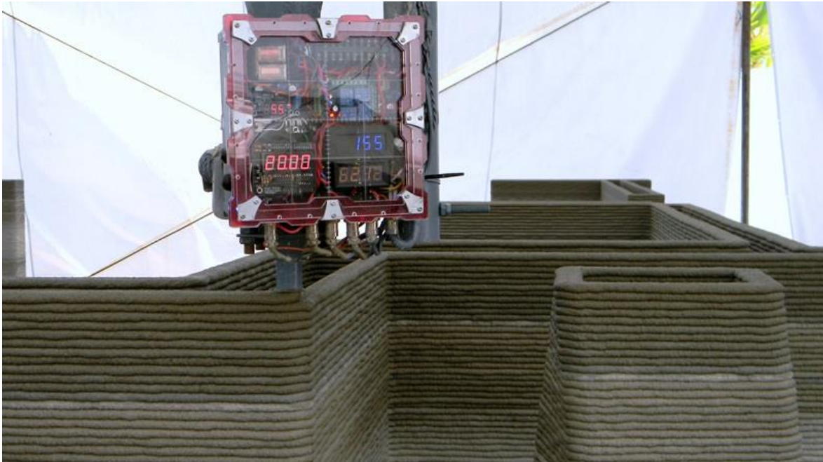
Obrázek 3.: Ukázka nanášení vrstev metodou vytlačování cementových malt [19]
