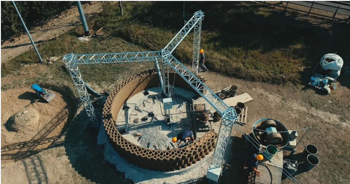
Obrázek 4.: Ukázka stavebního procesu domu GAIA na expozici "Viaggio a Shamballa" viz výše firmou WASP [10]
