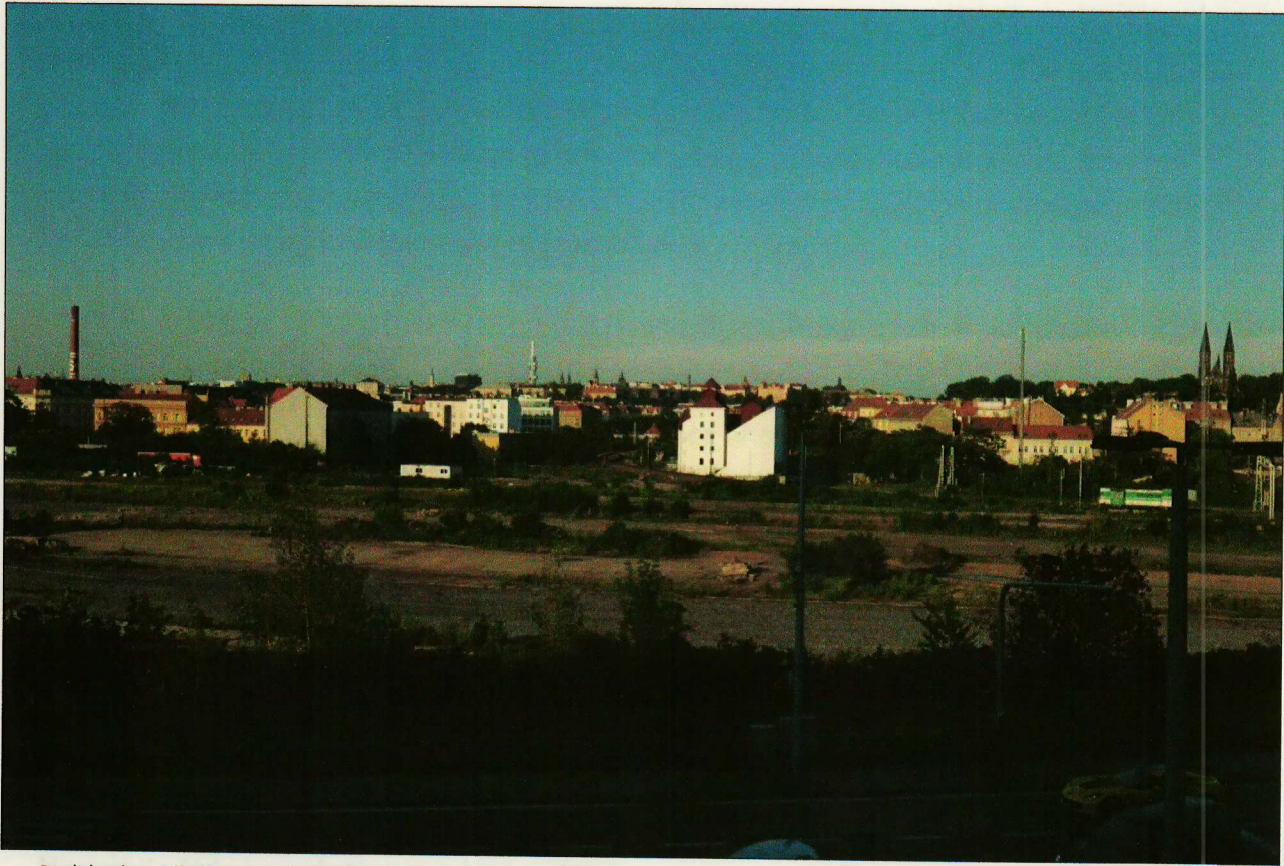
Pohled na řešenou lokalitu z úpatí Pavího vrchu nad tunelem Mrázovka
