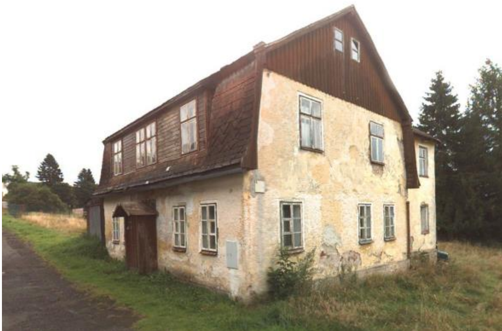
Obrázek 34- Objekt v Horní Blatné s vlhkostí a azbestovou krytinou [vytvoreno autorem]
