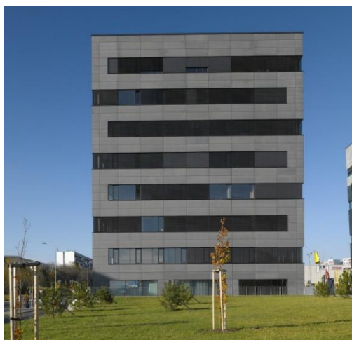
Obrázek č. 11 – Ukázka modulové fasády 45
