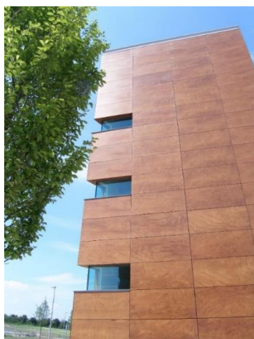
Obrázek č. 10 - Ukázka dřevěné fasády 42
