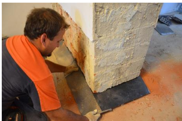
Obrázek 12 Vložení hydroizolační fólie
