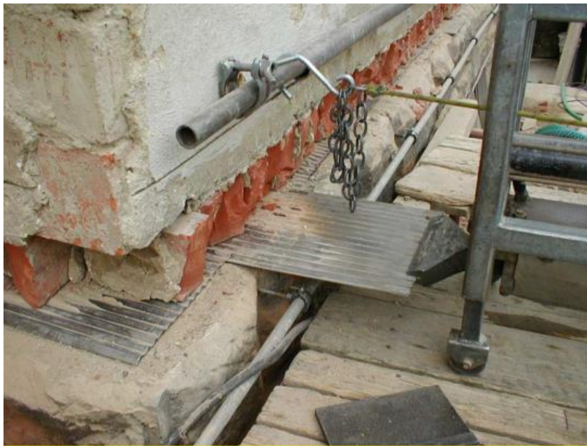
Obrázek 16 Vkládání nerezových plechů
