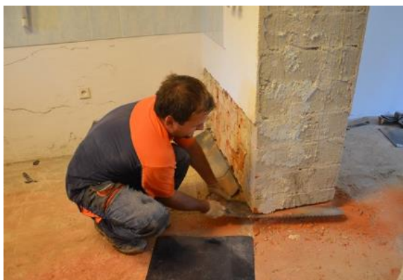
Obrázek 11 Vyčištění prořezané spáry
