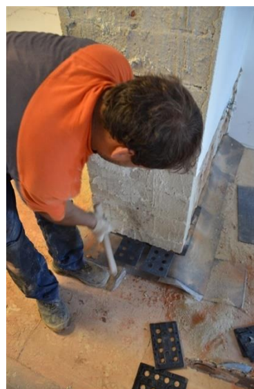
Obrázek 13 Zaklínování plastovými klíny
