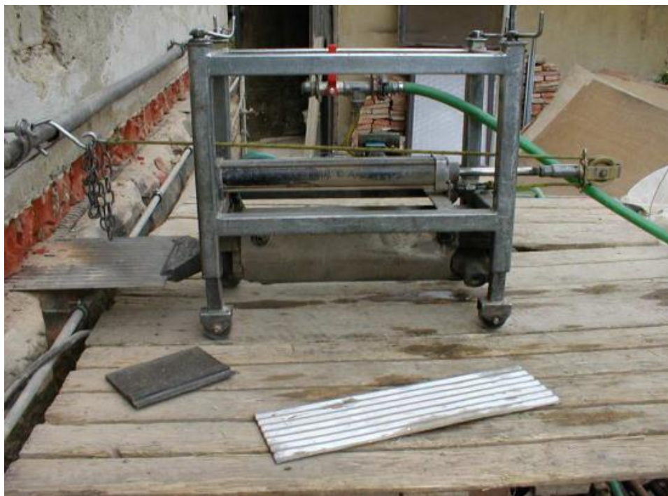
Obrázek 17 Vkládání nerezových plechů
