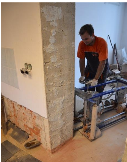
Obrázek 10 Podřezání cihelného zdiva
