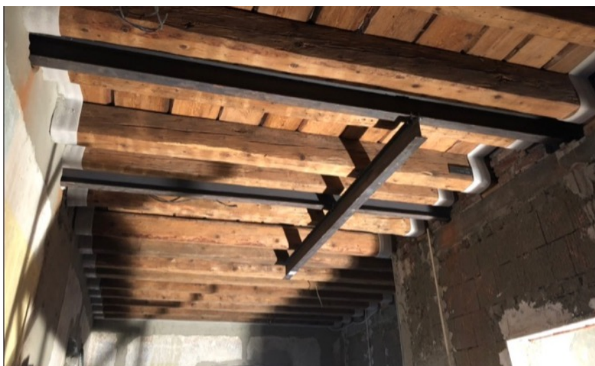
Obr 3.1 Zdvihací konstrukce [Autor]
