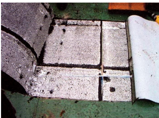
Obrázek 17: Rozevření spár v tepelné izolaci v důsledku objemových změn [3]
