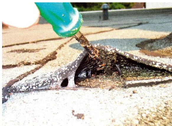
Obrázek 16: Nesprávné provedení hydroizolační vrstvy – pásy nebyly celoplošně nataveny [3]
