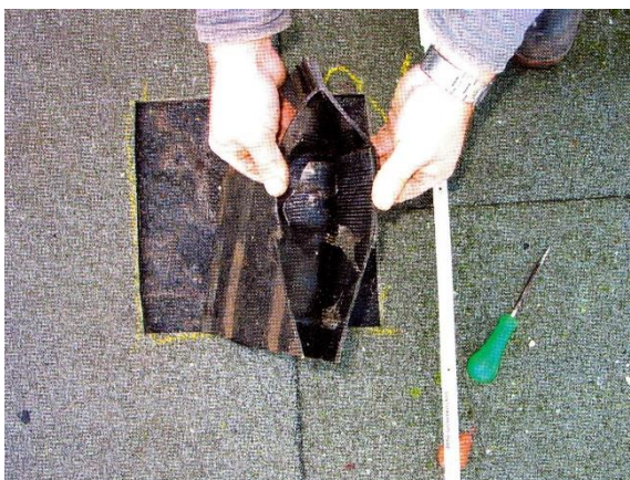
Obrázek 16: Nesprávné provedení hydroizolační vrstvy – pásy nebyly celoplošně nataveny [3]
