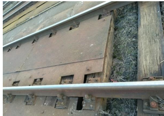
Obr. 3: Železniční svršek u opěry O2
