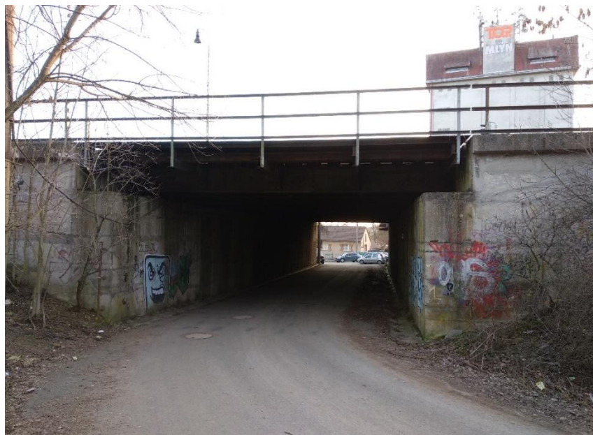
Obr. 1: Celkový pohled na most
