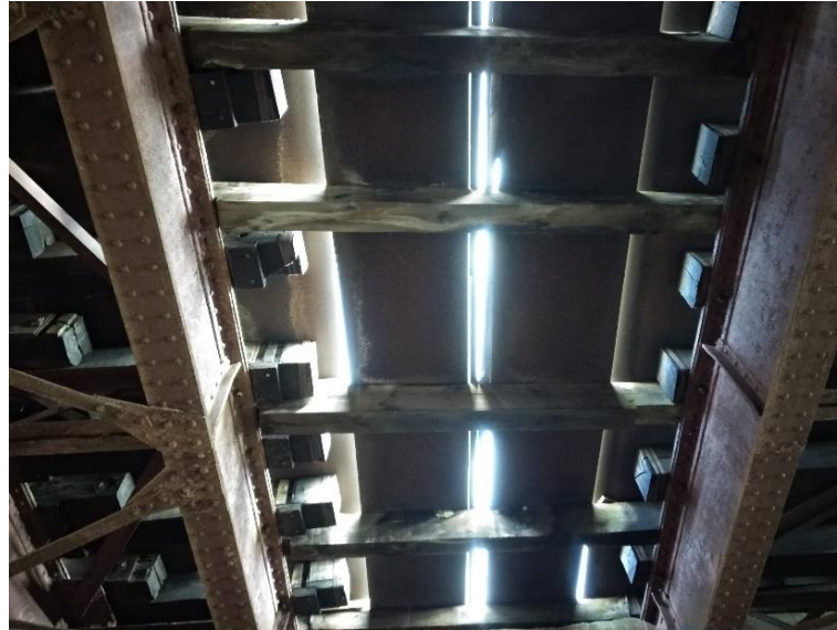
Obr. 9: Podlahové nosníky mezi konstrukcemi (zleva) K4 a K3
