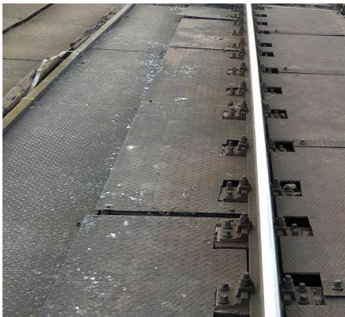
Obr. 8: Podlahové plechy a kabelový žlab
