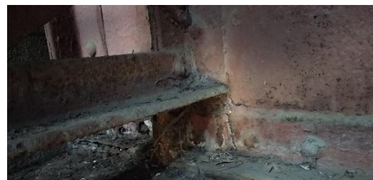
Obr. 69: Přípoj pasu příčného ztužení k hlavnímu nosníku
