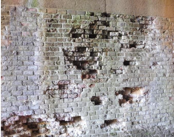
Obr. 14: Kaverny ve zdivu na opěře O2
