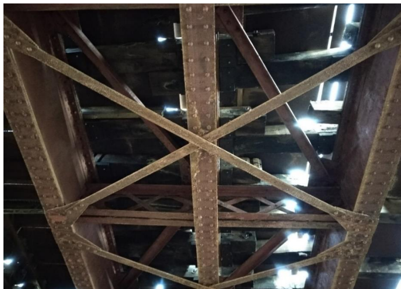
Obr. 5: Pohled zdola na nosnou konstrukci
