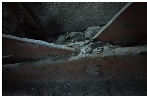
Obr. 70: Přípoj diagonál příčného ztužení k pasu
