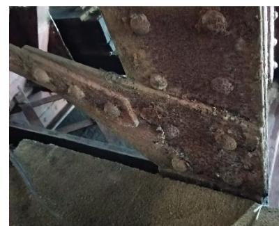
Obr. 68: Přípoj dolního ztužení
