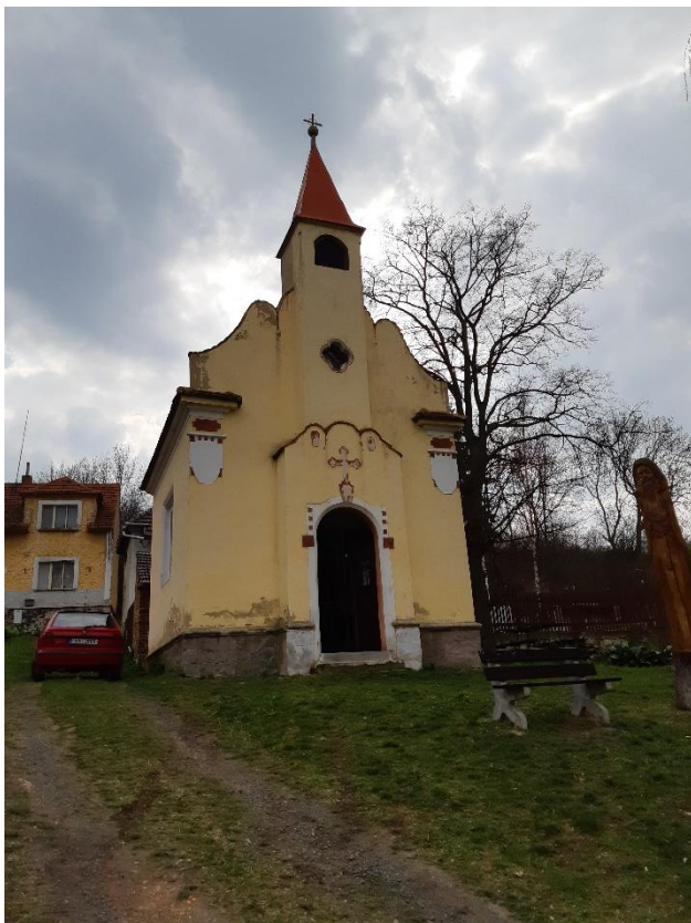
Obr. 2 – Pohled na průčelí kaple
