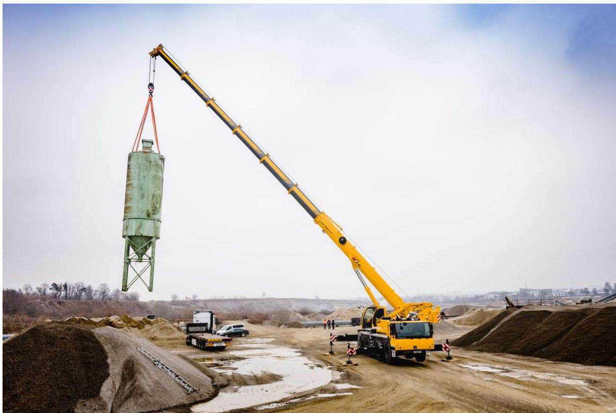
Obr. 6 Autojeřáb Liebherr LTM 1090-4.2 s teleskopickým výložníkem [9]
