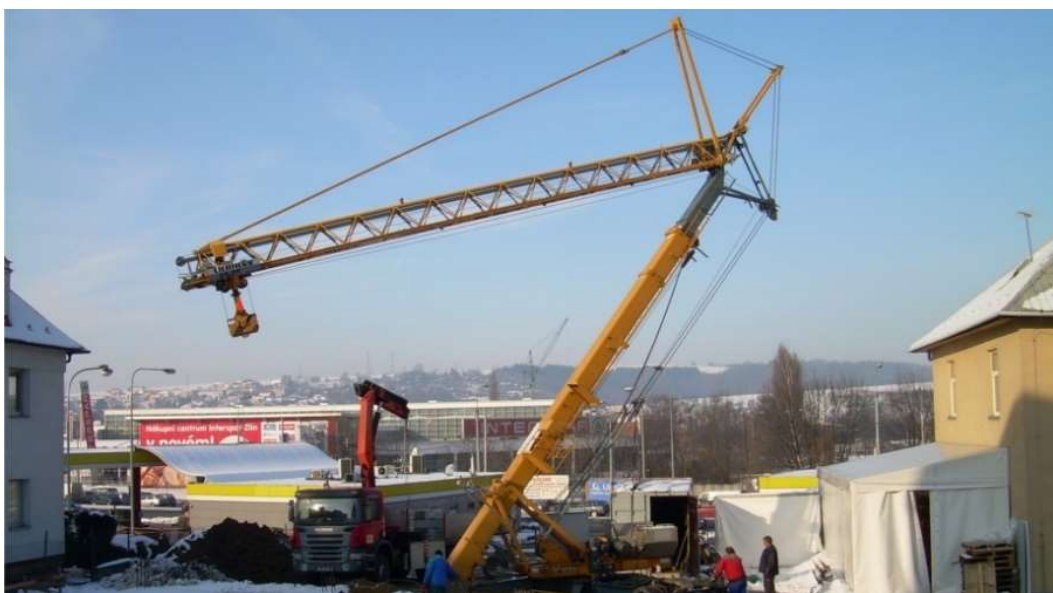
Obr. 10 Vztyčování jeřábu Liebherr 32 TT s teleskopickou věží [14]
