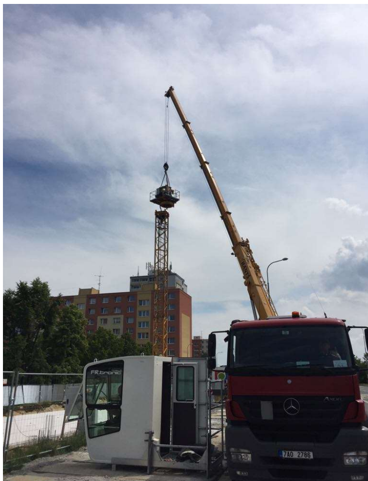
Obr. 23 Montáž jeřábu J2 Liebherr 80 LC [vlastní archiv]
