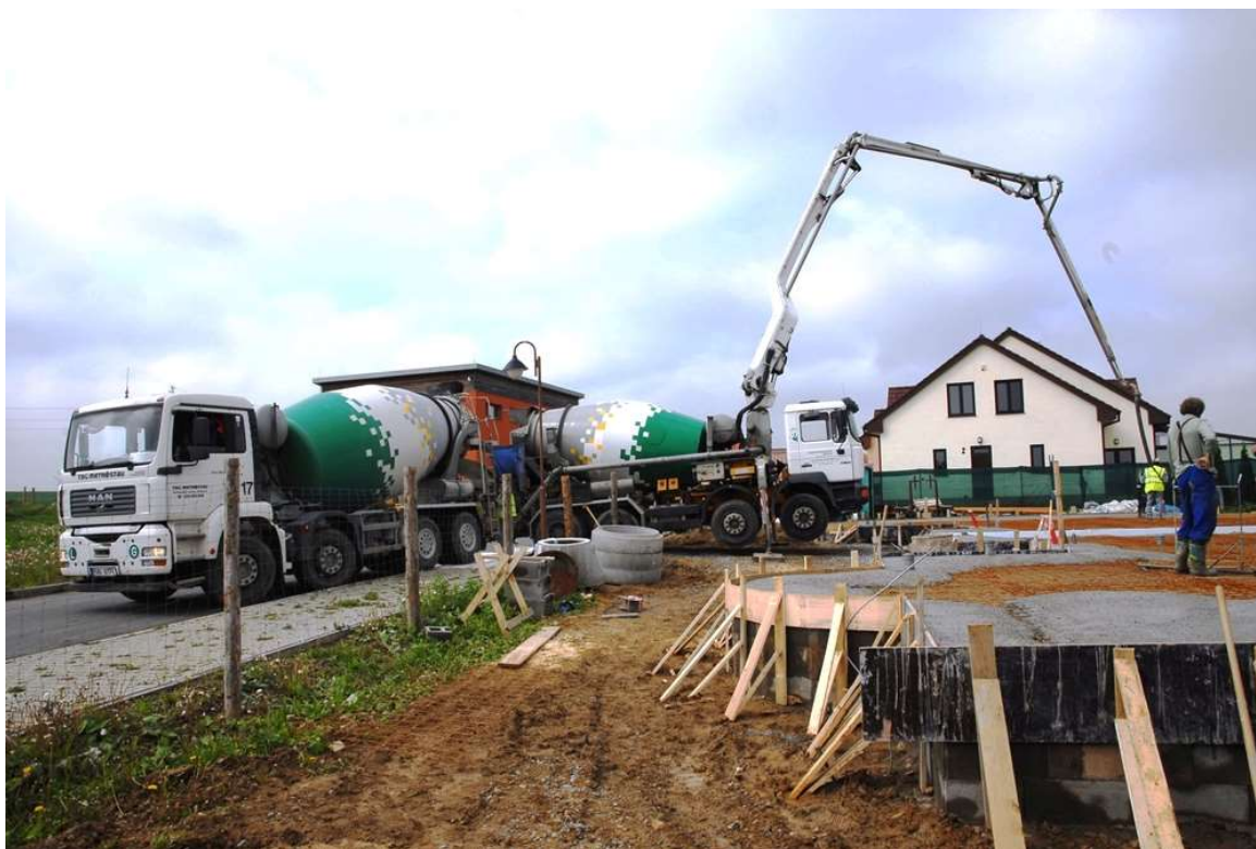
Obr. 19 Čerpání betonu na základy rodinného domu [22]
