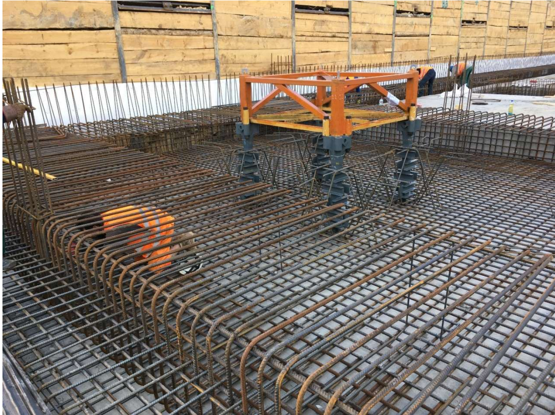
Obr. 26 Armování základové patky věžového jeřábu [vlastní archiv]
