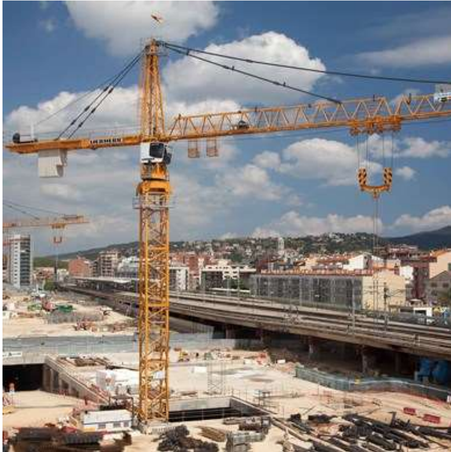
Obr. 15 Jeřáb s nosnou špicí Liebherr 630 EC-H 50 Litronic [18]
