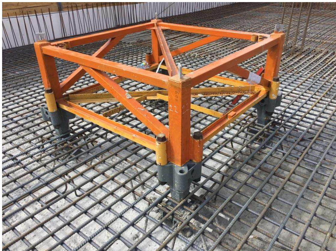
Obr. 27 Základová patka věžového jeřábu [vlastní archiv]
