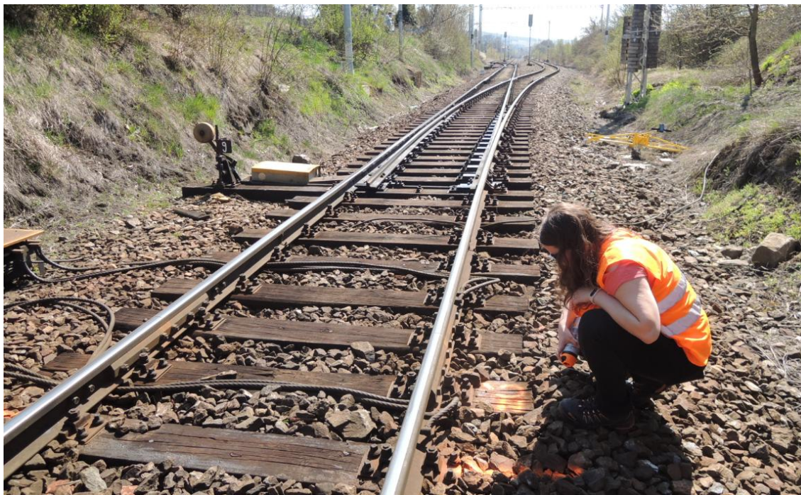
Obr. 5.2 - Pohled na začátek zkušebního úseku (směr žst. Blovice)
