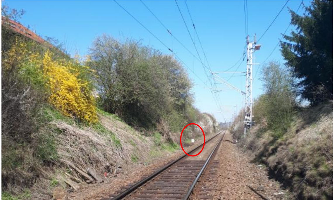
Obr. 6.17 - Pohled na hektometrovník 326,100 km - vztahný bod pro určení začátku zkušebního úseku
