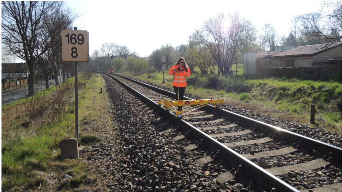
Obr. 6.16 - Pohled na hektometrovník 169,800 km - vztažný bod pro určení začátku zkušebního úseku
