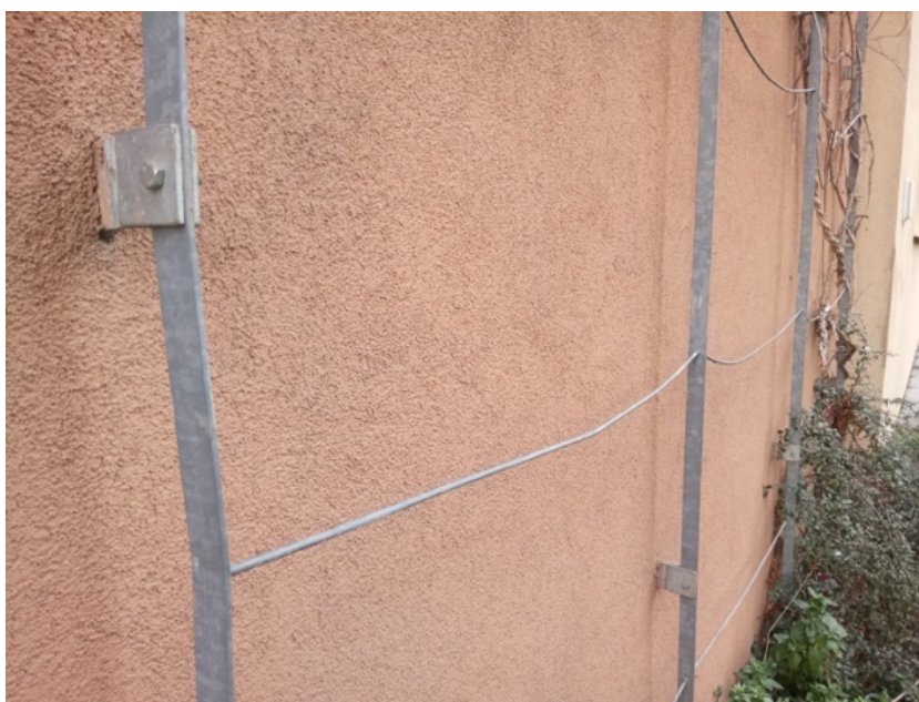
Obrázek 26: Uchycení kovové opěrné konstrukce k objektu [autor]
