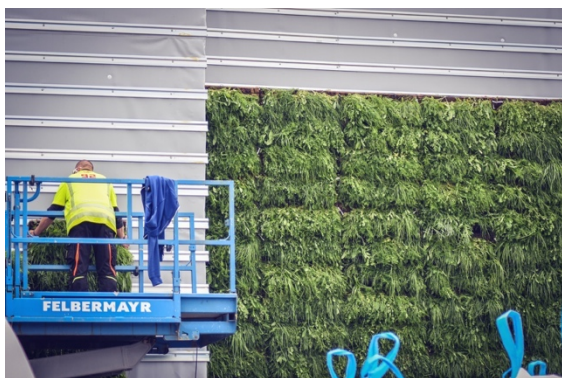
Obrázek 48: Mříž fasádních modulů [38]
