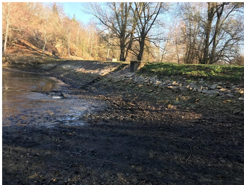
Obr. 31 Dno nádrže č. 3
