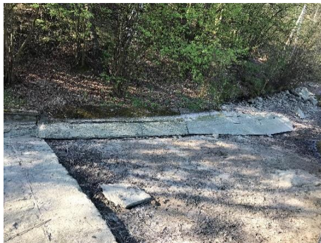
Obr. 15 Vtok do bezpečnostního přelivu nádrže č. 2
