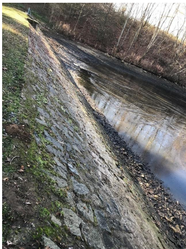
Obr. 26 Opevnění návodního líce nádrže č. 3
