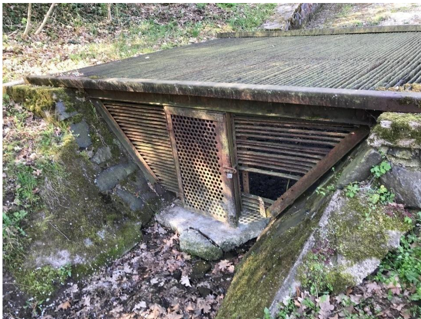
Obr. 17 Česle bezpečnostního přelivu nádrže č. 2
