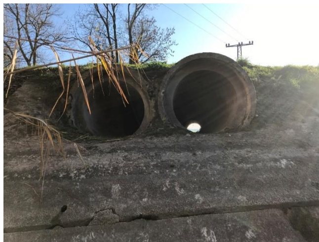
Obr. 7 Bezpečnostní přeliv nádrže č. 1
