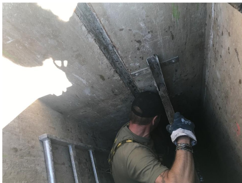
Obr. 23 Výpustný objekt nádrže č. 2
