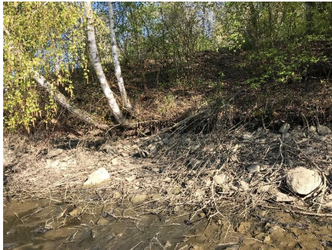
Obr. 11 Pravý břeh nádrže č. 2
