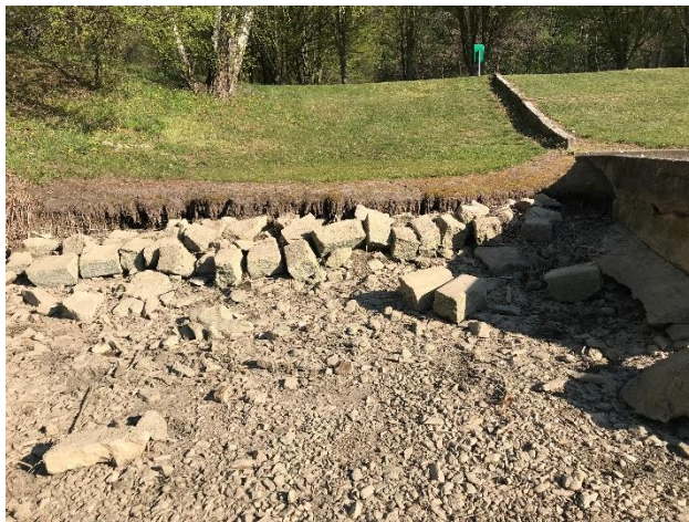
Obr. 10 Pravý břeh nádrže č. 2
