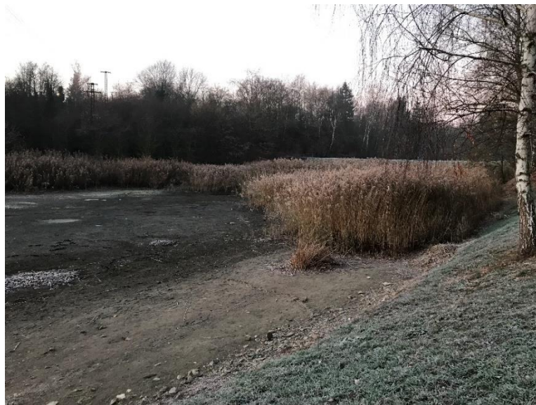
Obr. 4 Pravý břeh nádrže č. 1
