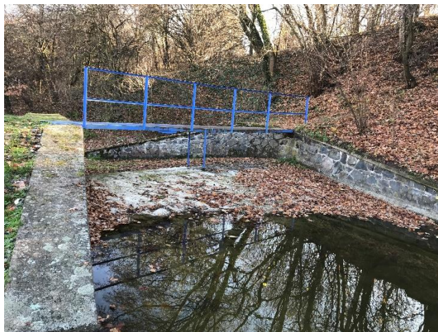
Obr. 18 Lávka přes bezpečnostní přeliv nádrže č. 2
