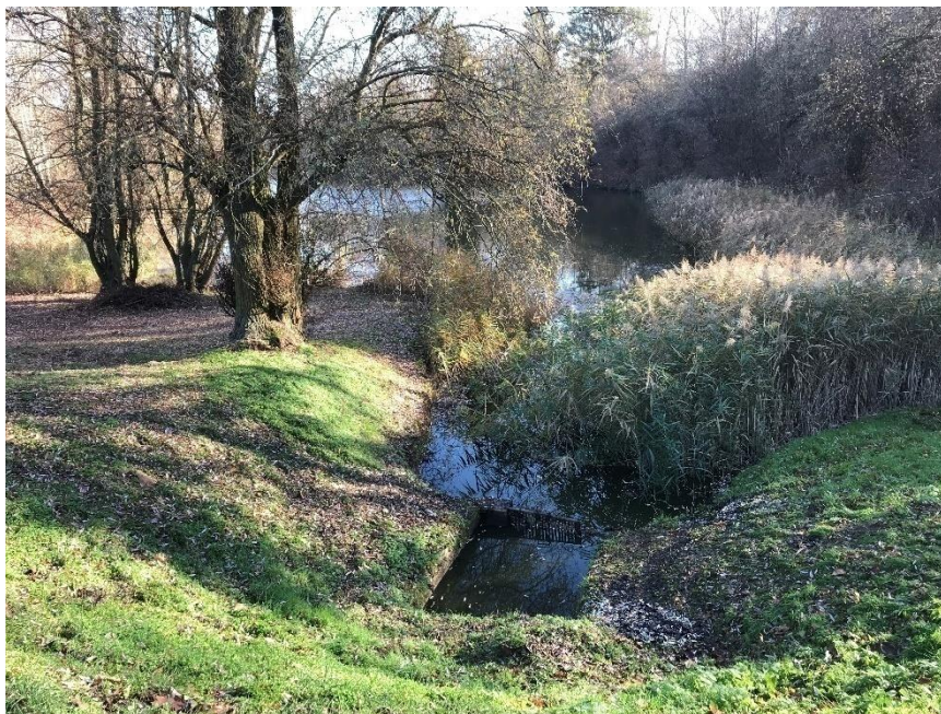
Obr. 27 Vzdušní líč nádrže č. 3
