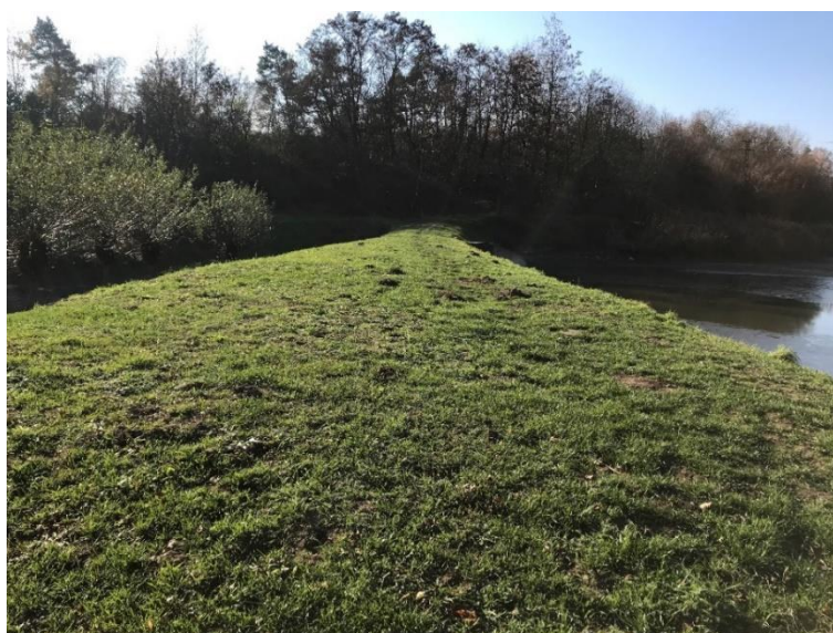
Obr. 5 Koruna hráze nádrže č. 1
