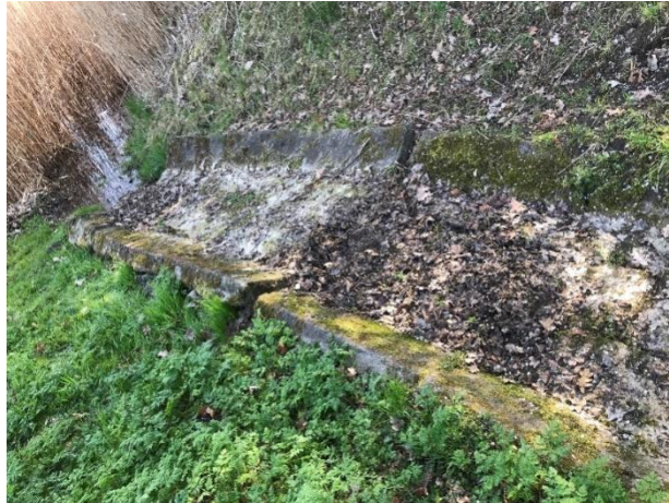
Obr. 20 Odpadní koryto bezpečnostního přelivu nádrže č. 2
