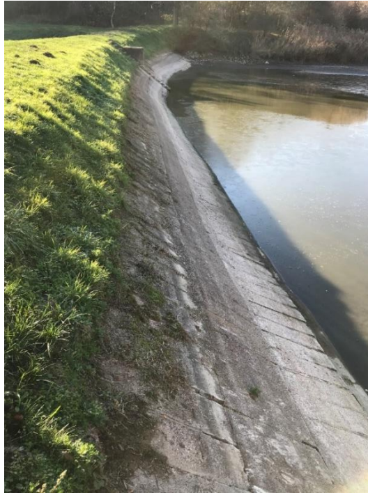
Obr. 6 Opevnění návodního líce nádrže č. 1
