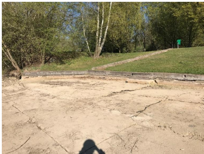
Obr. 13 Pravý břeh nádrže č. 2
