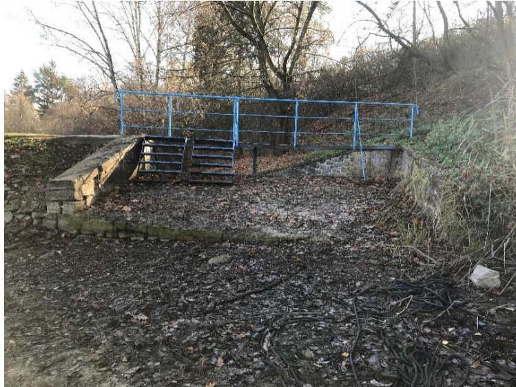
Obr. 28 Bezpečnostní přeliv nádrže č. 3
