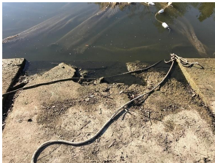
Obr. 12 Pravý břeh nádrže č. 2
