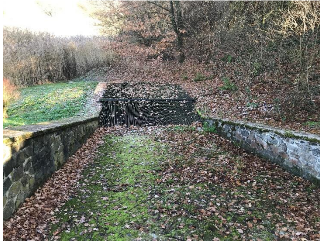
Obr. 14 Koryto bezpečnostního přelivu nádrže č. 2
