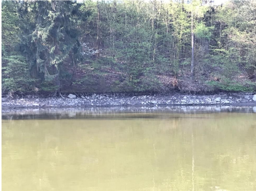
Obr. 9 Levý břeh nádrže č. 2
