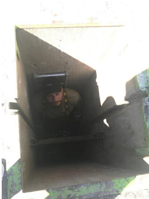
Obr. 21 Výpustný objekt nádrže č. 2
