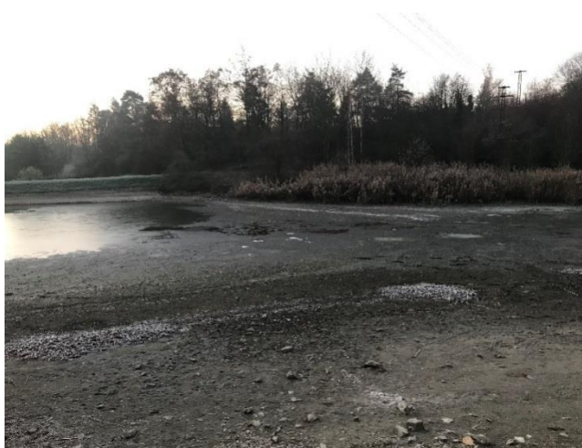
Obr. 3 Levý břeh nádrže č. 1
