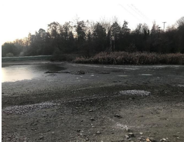
Obr. 8 Dno nádrže č. 1
