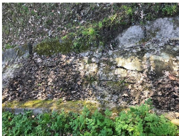
Obr. 19 Odpadní koryto bezpečnostního přelivu nádrže č. 2
