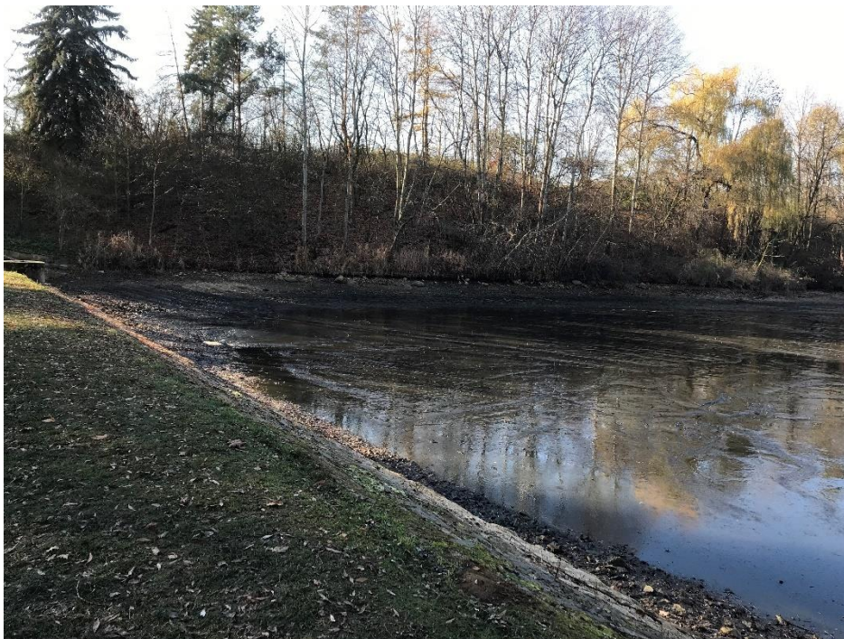
Obr. 25 Koruna hráze nádrže č. 3
