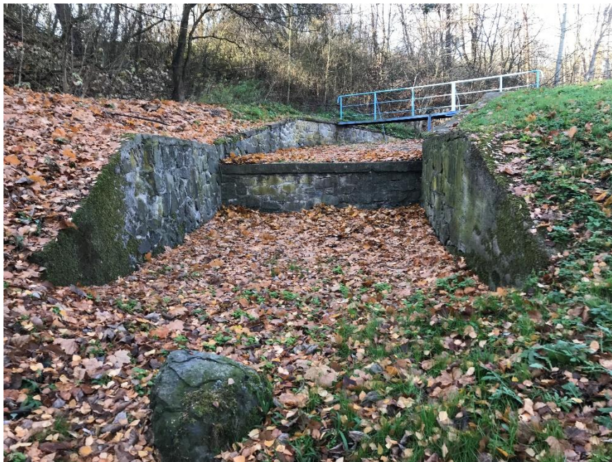
Obr. 29 Odpadní koryto bezpečnostního přelivu nádrže č. 3
