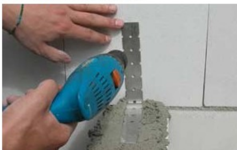
Kotvení příček dodatečně
