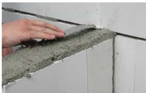
Kotvení příček při zdění nosné stěny
