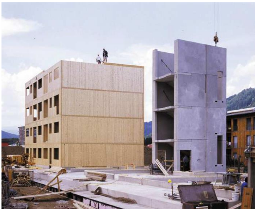
Obrázek 24 - použití železobetonového ztužujícího jádra
