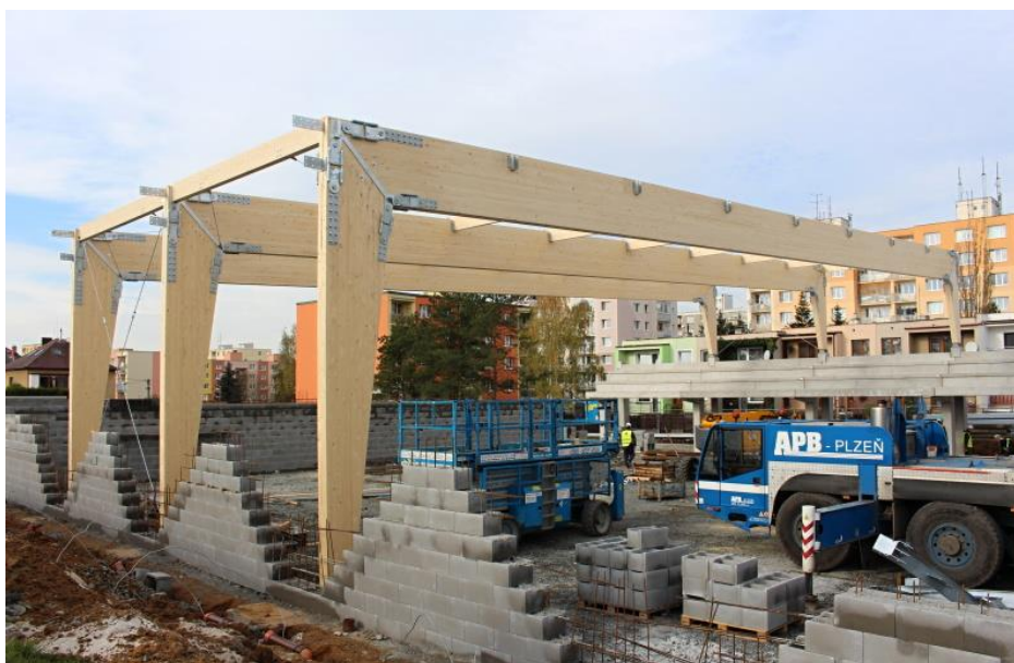
Obrázek 5 - průvlak halové konstrukce
