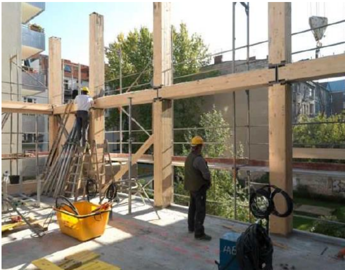
Obrázek 36 - konstruování skeletu e3BAU
