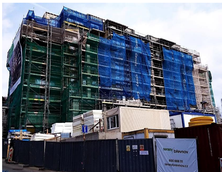
Obr. 4.1 – Rezidence RADIMOVA – výstavba, [zdroj: vlastní]
