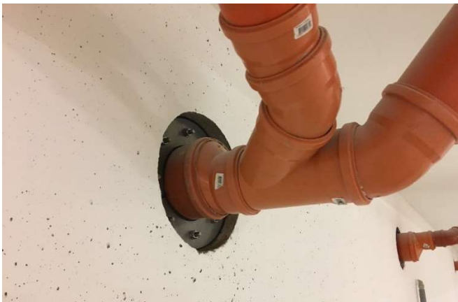
Obrázek 28 (vlevo): Prostup kanalizačního KG potrubí stěnou Obrázek 29 (vpravo): Prostup kabelů stěnou
