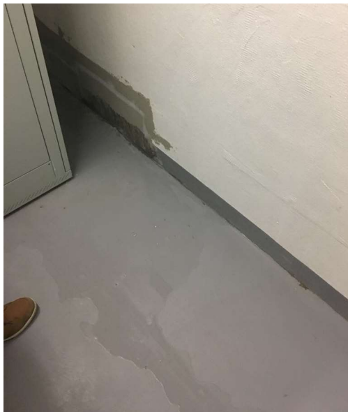
Obrázek 64 (vlevo): Místo infiltrace vody do technické místnosti ve 2.PP bytového domu
