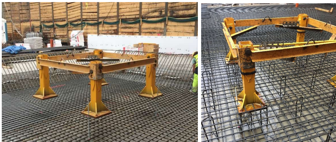
Obrázek 30 (vlevo): Základový kříž věžového jeřábu osazený v ZD, foto v průběhu armování
