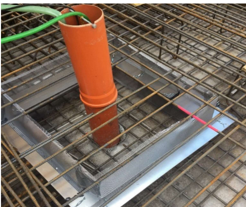
Obrázek 34 (vlevo): Pracovní spára v okolí čerpací studny - bitumenové plechy
