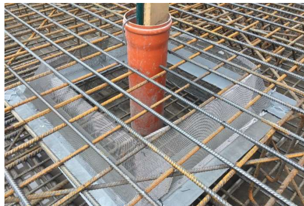
Obrázek 34 (vlevo): Pracovní spára v okolí čerpací studny - bitumenové plechy
