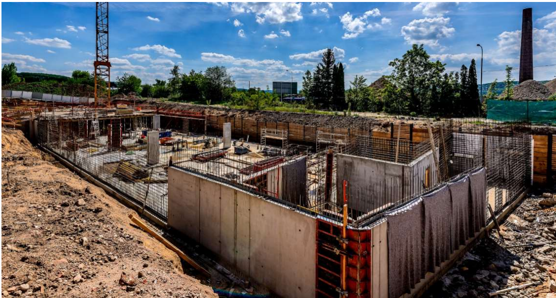
Obrázek 1: Foto z realizace „bílé vany“, stavba Neoriviera, Praha – Modřany
