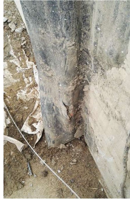
Obrázek 58 (vlevo): Pohled na svislou dilataci poruchového místa (dilatace mezi stávajícím objektem etapy "B" a napojovaným objektem etapy "A")
