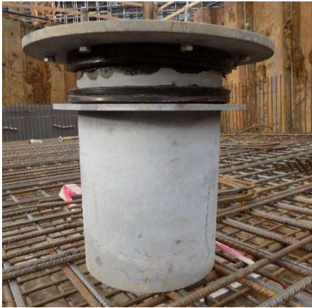
Obrázek 32 (vlevo): Ocelová manžeta vkládaná jako těsnění do čerpacích studní
