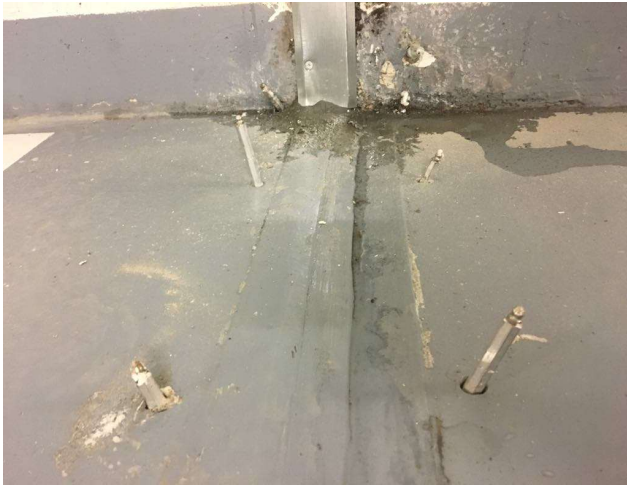
Obrázek 47 (vlevo): Neúspěšně provedená sanace injektážní pakry
