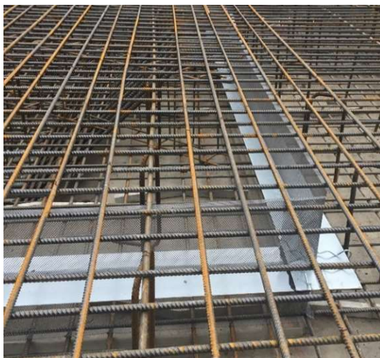
Obrázek 11 (vlevo): Namontované těsnicí plechy s bentonitovým povrstvením před betonáží základové desky (pracovní spára ZD/ZD) Zdroj: autor BP
