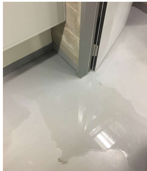
Obrázek 64 (vlevo): Místo infiltrace vody do technické místnosti ve 2.PP bytového domu
