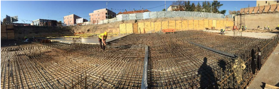
Obrázek 55: Foto řešeného objektu ve fázi realizace základové desky - stavba Neoriviera, fáze „A“, Praha – Modřany Zdroj: autor BP
