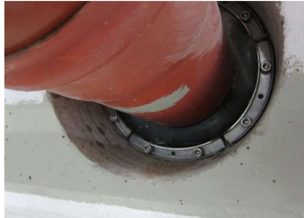
Obrázek 62 (vlevo): Těsnění prostupů Bettra HSD – ilustrační fotografie
