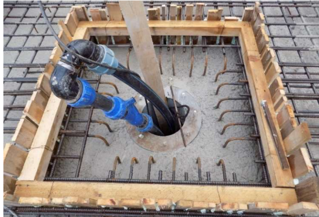
Obrázek 32 (vlevo): Ocelová manžeta vkládaná jako těsnění do čerpacích studní
