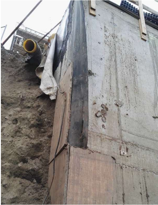
Obrázek 58 (vlevo): Pohled na svislou dilataci poruchového místa (dilatace mezi stávajícím objektem etapy "B" a napojovaným objektem etapy "A")
