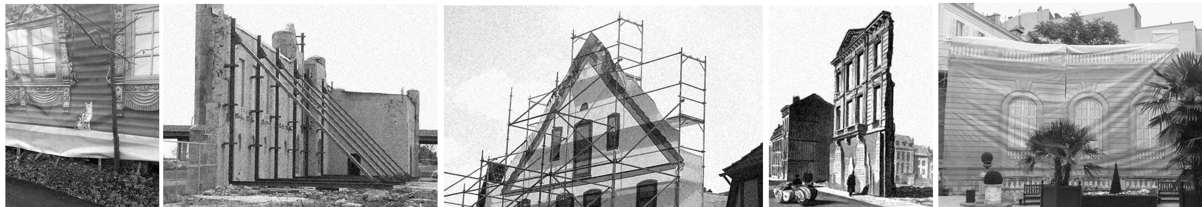
Fasáda ako ilúzia existujúceho domu, schránka vymedzujúca priestor.
