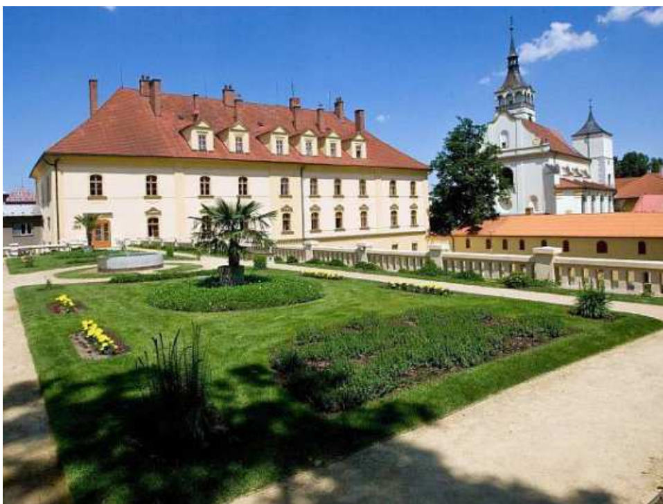
Obr. 2: Pohled na vegetační střechu nad konírnu na Zámku v Lipníku nad Bečvou [23]
