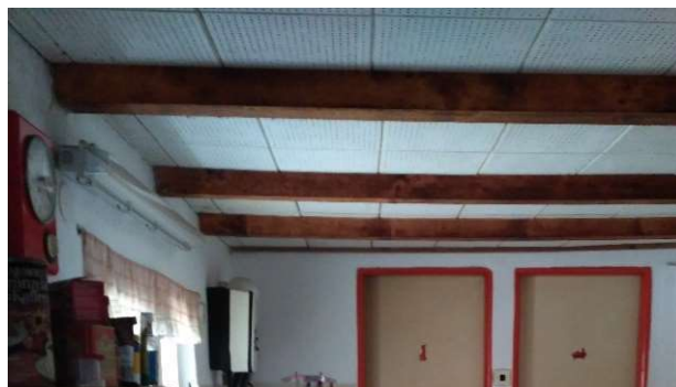
Obrázek 3.7 Trámový strop v kuchyni (zdroj: vlastní foto)
