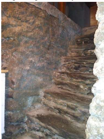
Obrázek 3.3 Schodiště spojující přízemí a suterén (zdroj: vlastní foto)
