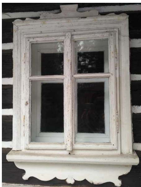
Obrázek 3.10 Detailní pohled na zdobné okno v roubené stěně (zdroj: vlastní foto)
