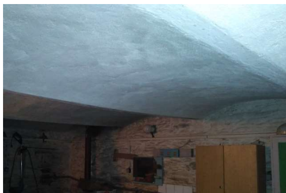
Obrázek 3.5 Obloukový strop sklepa (zdroj: vlastní foto)
