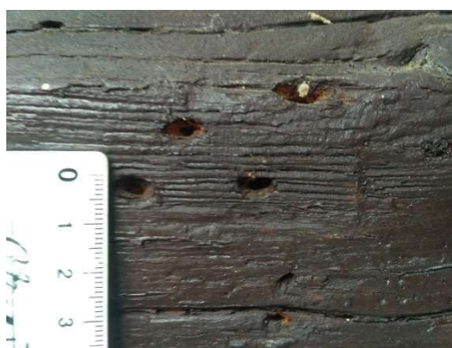
Obrázek 3.15 Větší díry po tesaříkovi (zdroj: vlastní foto)
