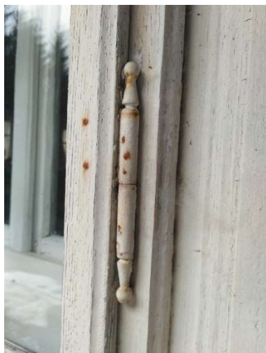
Obrázek 3.33 Detailní pohled na rám okna se zavěšením (zdroj: vlastní foto)
