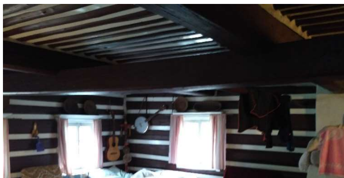
Obrázek 3.16 Prohnutý průvlak ve světnici (zdroj: vlastní foto)
