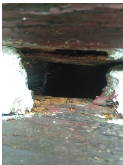
Obrázek 3.12 3Otvor po hlodavci (zdroj: vlastní foto)
