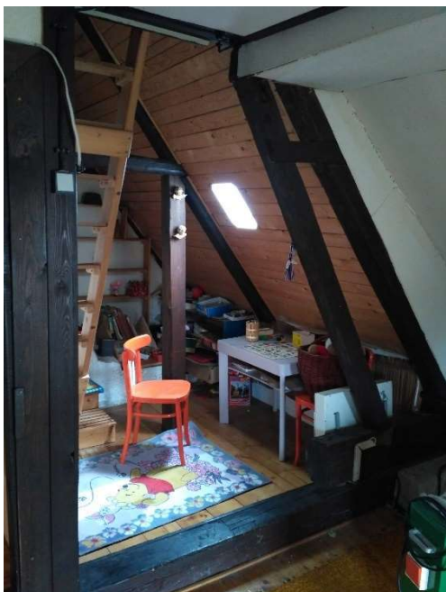
Obrázek 3.8 Pohled na sloupek držící hambalek a na ležatou stolici (zdroj: vlastní foto)
