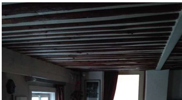
Obrázek 3.6 Povalový strop v ložnici (zdroj: vlastní foto)
