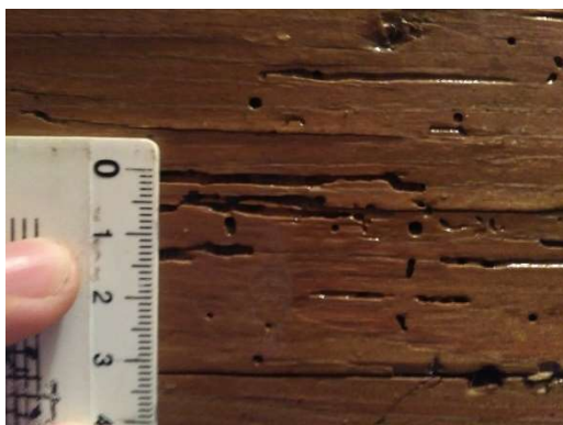
Obrázek 3.14 Chodbičky a díry po červotočích (zdroj: vlastní foto)
