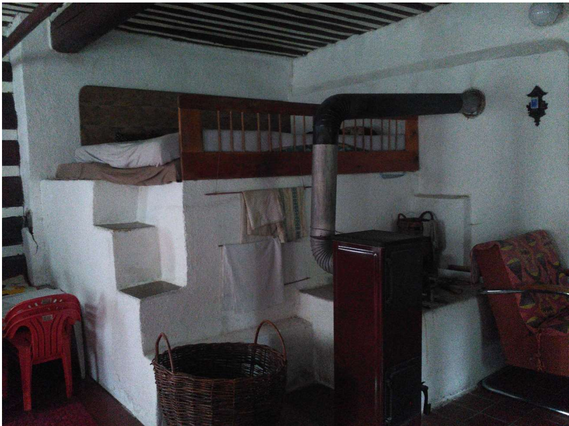
Obrázek 4.1 Stávající vzhled pece s kamny (zdroj: vlastní foto)
