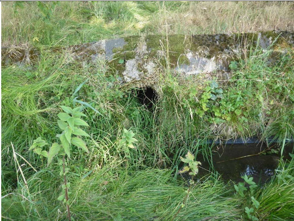
Obrázek 7 Zaústění meliorační trouby
