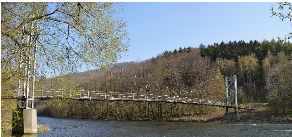
Obr. 1 Pohled na lávku z levého břehu řeky
