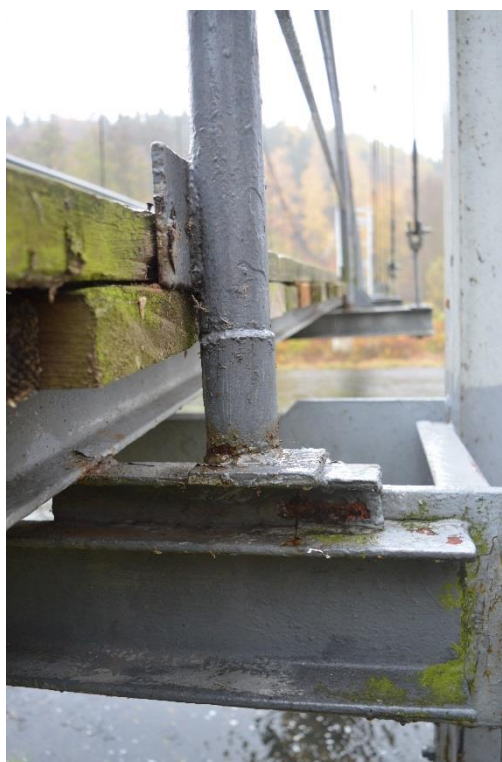
Detail uložení podélného nosníku na pylon
