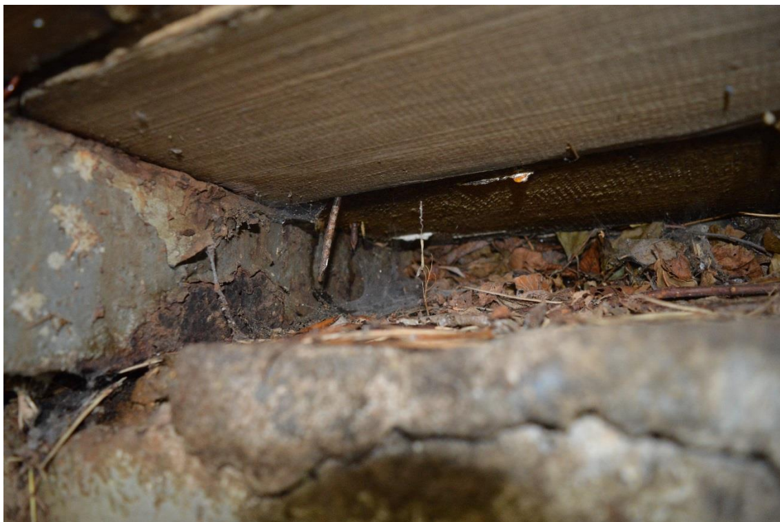
Detail uložení podélného nosníku na opěru
