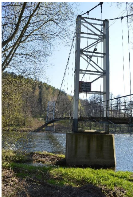
Obr. 2 Pohled na levobřežní pylon
