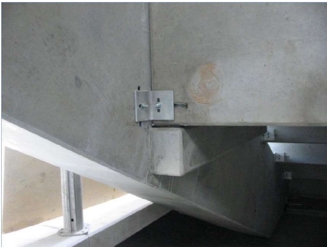
Obr. 6.1.2-3 – Kotvení lavicového nosníku v O 2 aréne [47]
