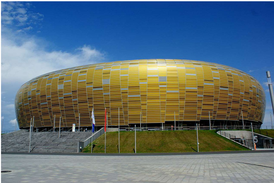
Obr. 3.3-11 – Stadion Energa Gdańsk, Gdańsk, Polsko [43]
