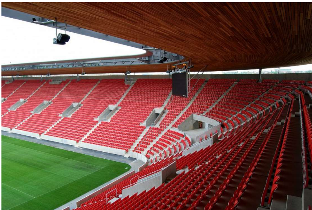
Obr. 3.3-5 – Sinobo Stadium, Praha, ČR [37]
