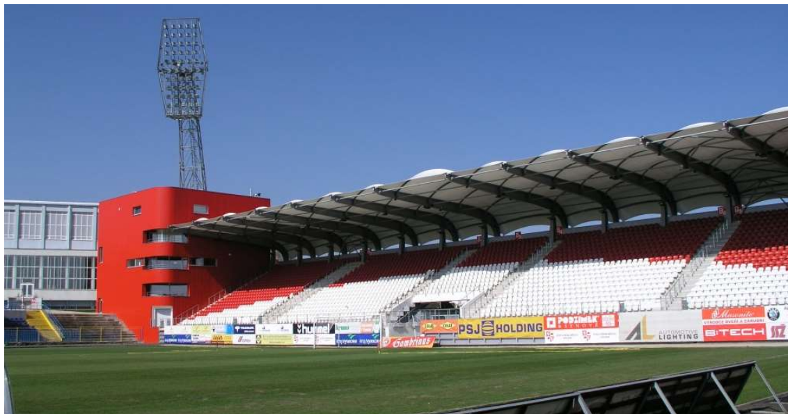
Obr. 3.3-2 – Stadion v Jiráskově ulici, Jihlava, ČR [34]
