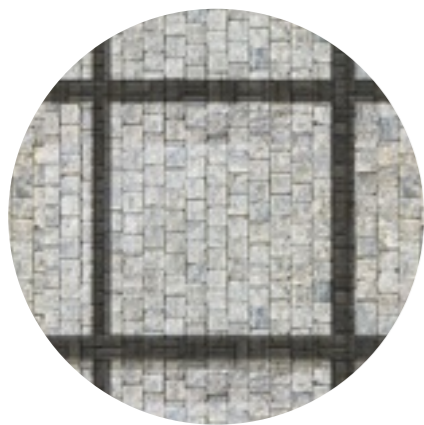
P.1 chodníky navazující na ulici Rohanské nábřeží a chodníky navrženého nábřeží čtverce ze světlých a tmavých žulových kostek 6x6 mm
