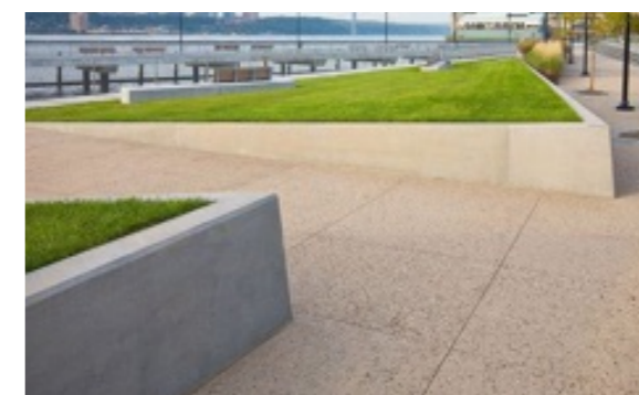
M.12 vyvýšená travnatá plocha, zídka z pohledového betonu
