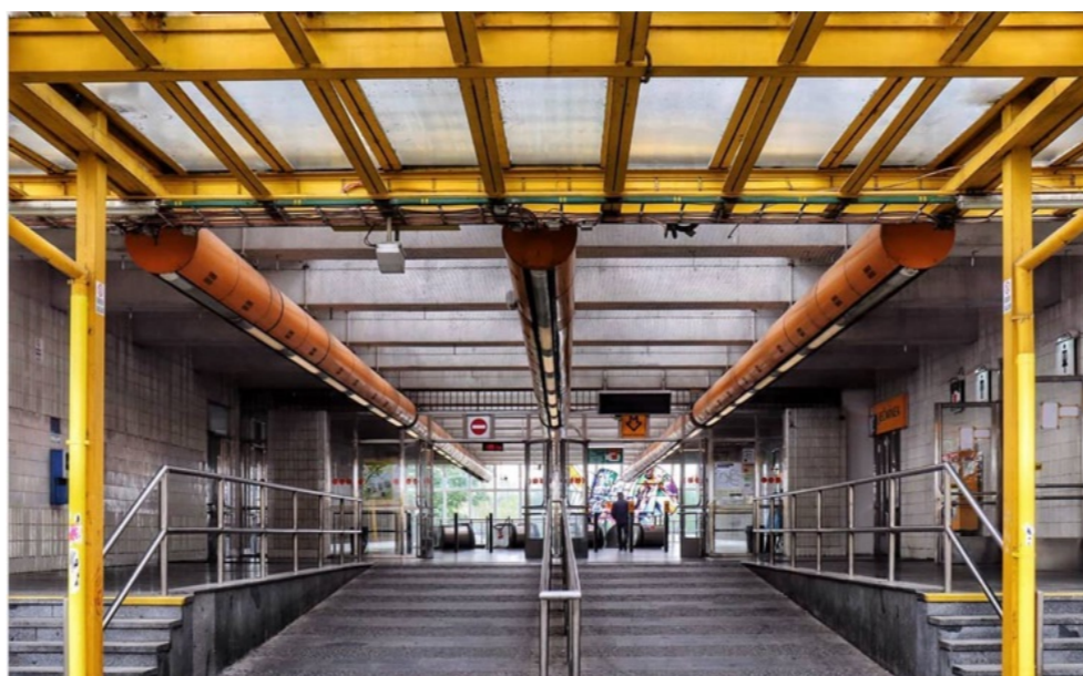
H) vstup do stanice metra Invalidovna
