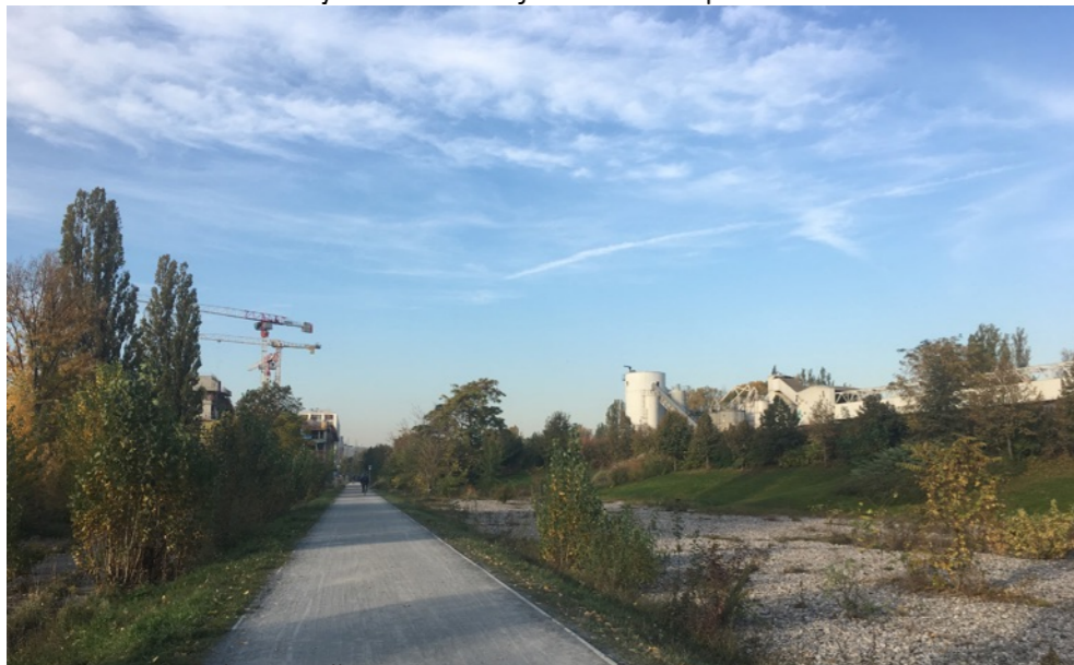
4.) pohled na západ směrem ke zastavovanému území, po pravé straně betonárka TBG Metrostav, s. r. o.
