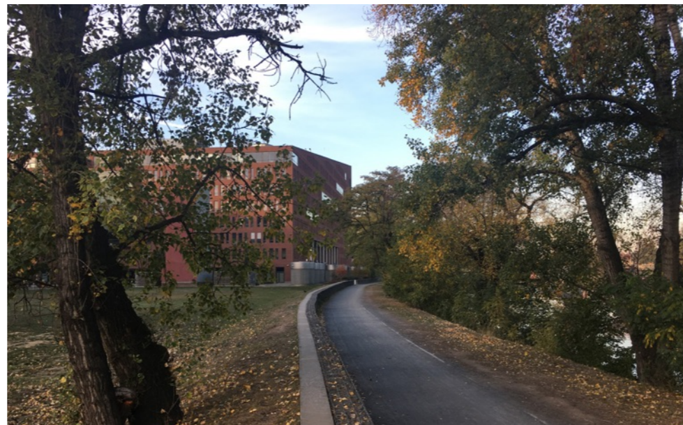
2.) cyklostezka slouží současně jako protipovodňová zábrana
