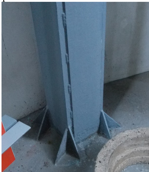
Obrázek 20 Pata vnějšího sloupu
