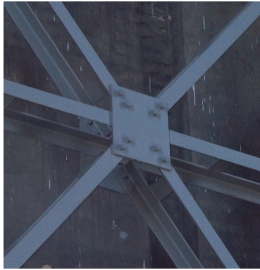
Obrázek 16 Styčnick vnějších diagonál
