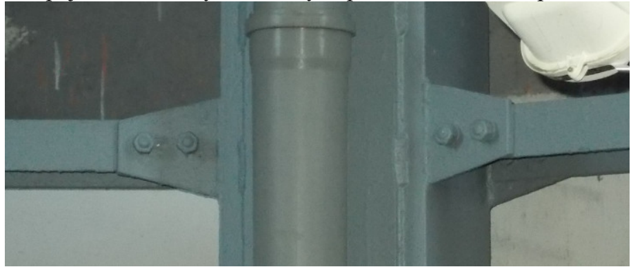
Obrázek 17 Napojení vodorovných členěných prutů na hlavní sloup
