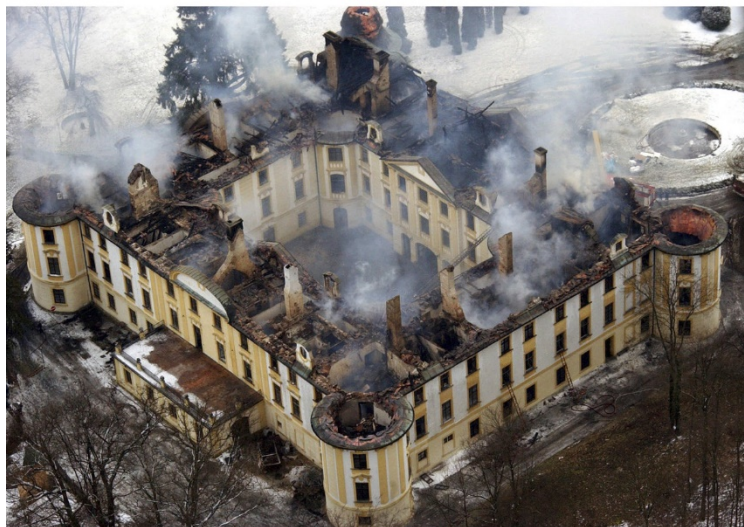
Obr. 3 Škody způsobené požárem na zámku Zahrádky (7)
