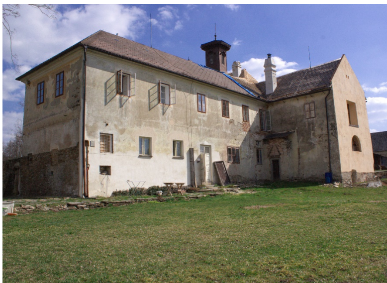
Obr. 21 Jihozápadní strana zámku (Autor)
