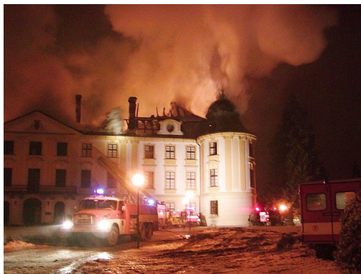
Obr. 2 Požár zámku Zahrádka (7)
