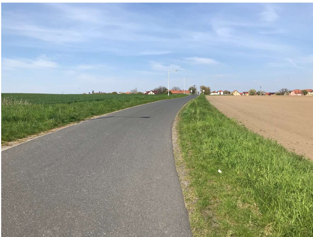
5) KM: 1,660 00 – Místo přemostění silnice III/32926n
