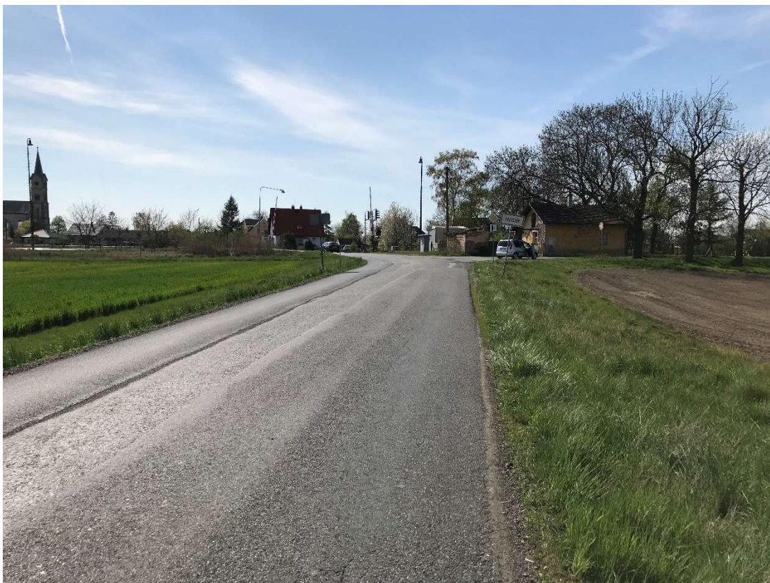
4) KM: 1,288 64 – Místo přemostění silnice III/32923
