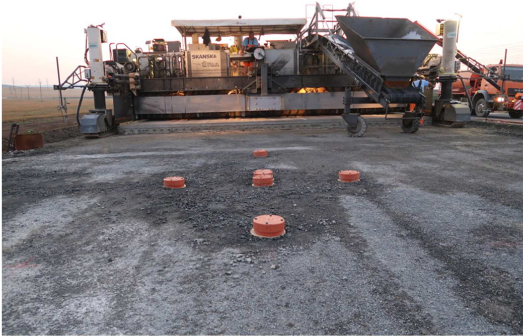
Obr. 38: Rozmístění čidel před pojezdem finišeru (foto S. Šulc)
