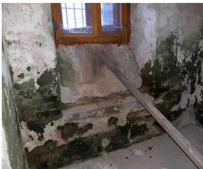
Obrázek 15: Pohled na vnitřní stěnu 1.PP – smíšené zdivo
