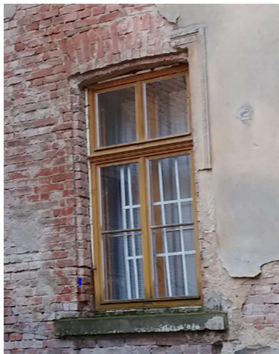
Obrázek 23: Cihelný klenutý pás nad okenním otvorem
