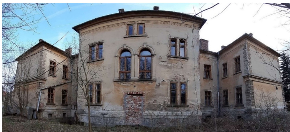
Obrázek 3: Pohled na severní fasádu objektu
