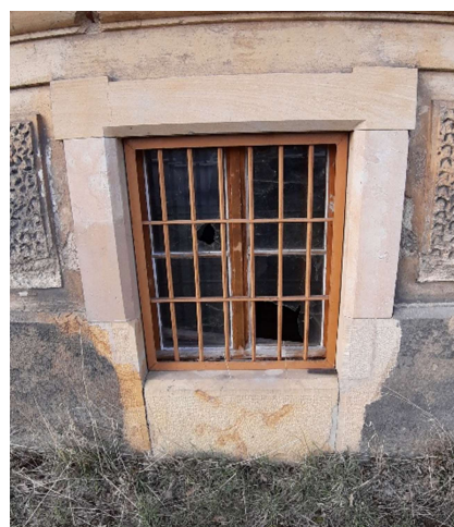
Obrázek 33: Dřevěné dvojitě okno suterénu opatřeno mříží
