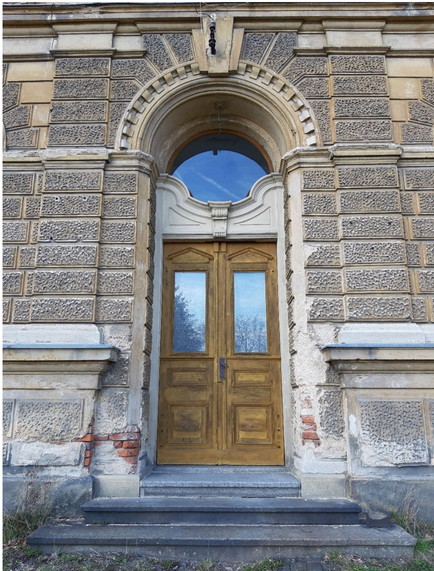
Obrázek 34: Hlavní vchodové dveře a atypické osově symetrické okno s pevným zasklením osvětlující vestibul objektu
