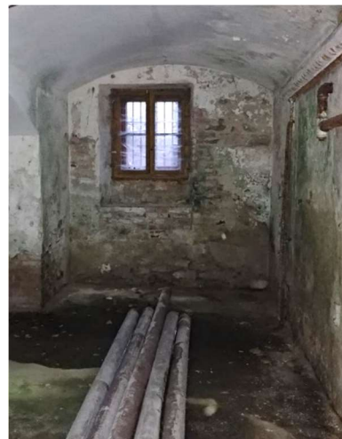
Obrázek 19: Stropní konstrukce suterénu – valená klenba klenutá do nosné zdi a klenutého pásu
