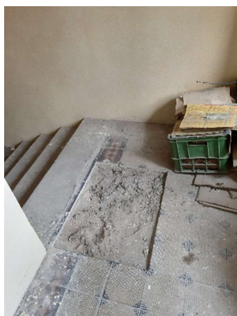
Obrázek 55: Chybějící kamenná dlažba na mezipodestě schodiště
