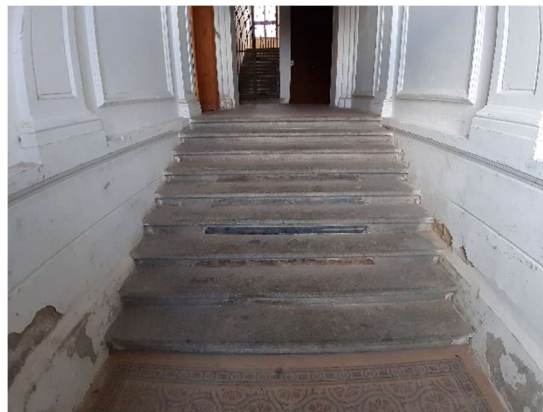
Obrázek 25: Schodiště ze zádveří do úrovně podlahy 1.NP
