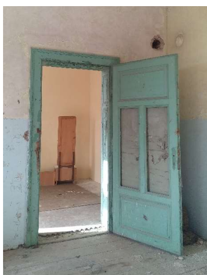
Obrázek 35: Jednokřídlé dřevěné dveře interiéru
