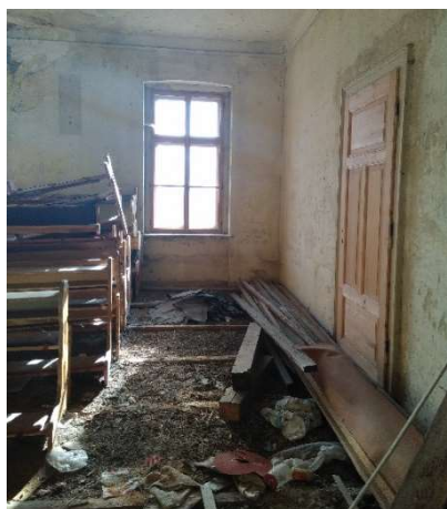
Obrázek 56: Odkrytý násyp a polštáře podlahy 2.NP
