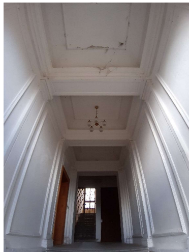
Obrázek 18: Stropní konstrukce vestibulu – zrcadlová klenba do traverz
