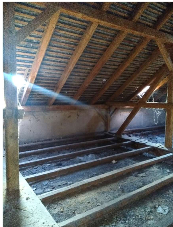
Obrázek 20: Dřevěný trámový strop 2.NP
