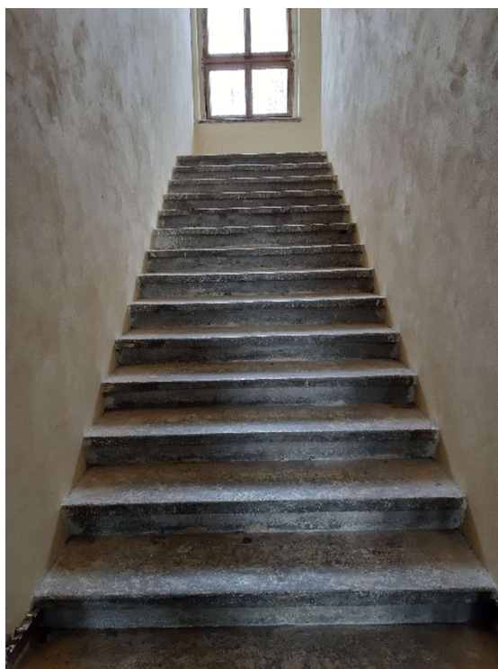
Obrázek 26: Hlavní vertikální komunikace objektu
