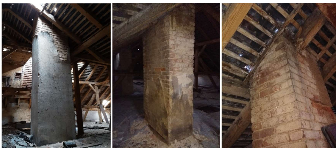
Obrázek 52: Narušení omítky vlivem usazujícího se dehtu a její následný rozpad
