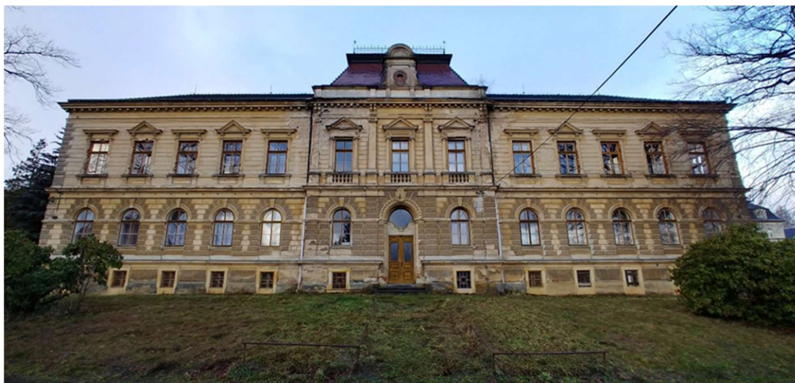
Obrázek 2: Pohled na hlavní vstup do budovy – jižní fasáda objektu
