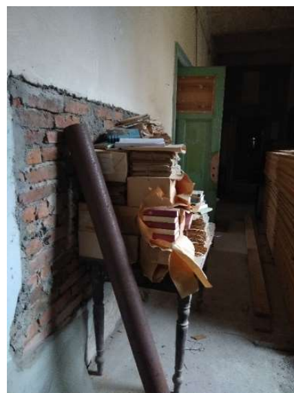
Obrázek 16: Pohled na vnitřní stěnu 2.NP – cihly plně pálené klasického formátu – běhounová vazba
