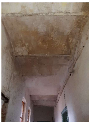
Obrázek 17: Stropní konstrukce chodby 2.NP – valená klenba do traverz
