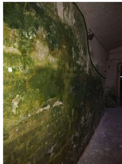
Obrázek 66: Rozložení vlhkosti na svislé zděné stěně suterénu
