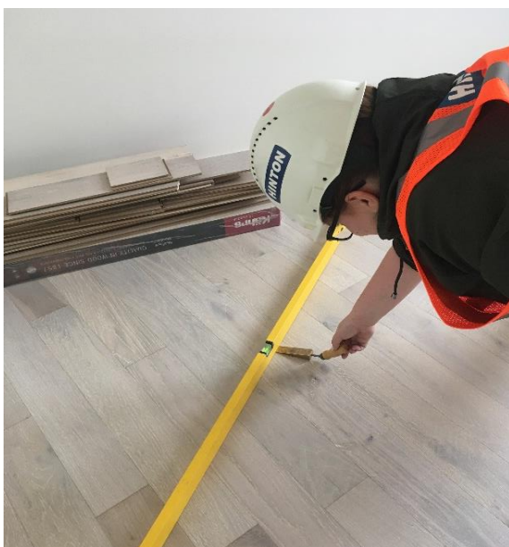
Obr. 21 – Měření místní rovinnosti v bytě 1.05
