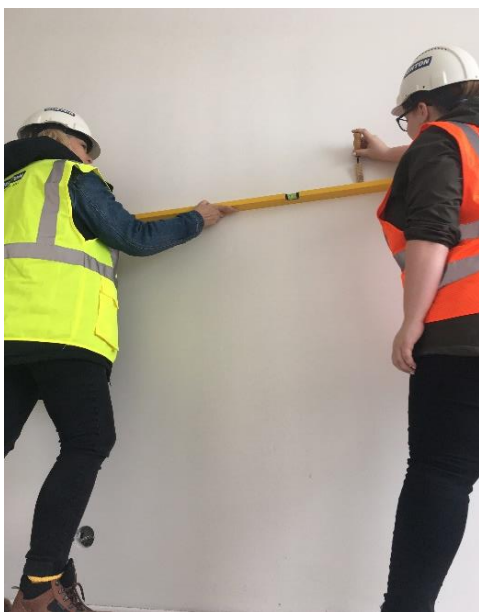
Obr. 9 – Měření v bytě 2.04
