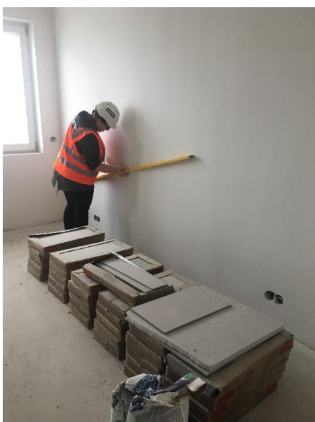
Obr. 18 – Měření v bytě 1.05
