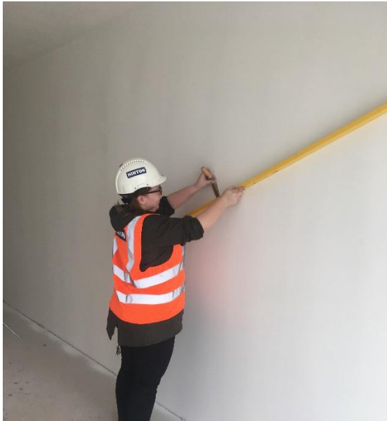
Obr. 12 – Měření v bytě 4.08
