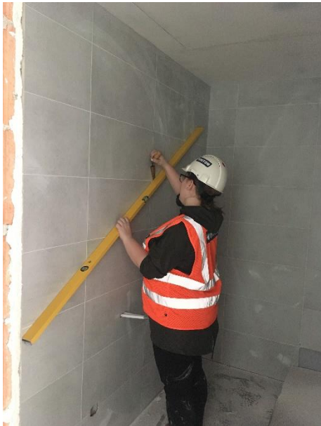
Obr. 25 – Měření místní rovinnosti
