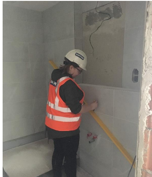
Obr. 25 – Měření místní rovinnosti
