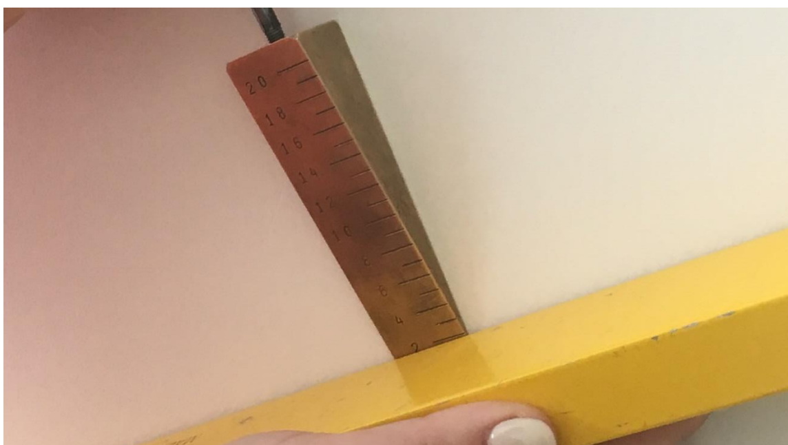
Obr. 15 – Měření v bytě 3.09
