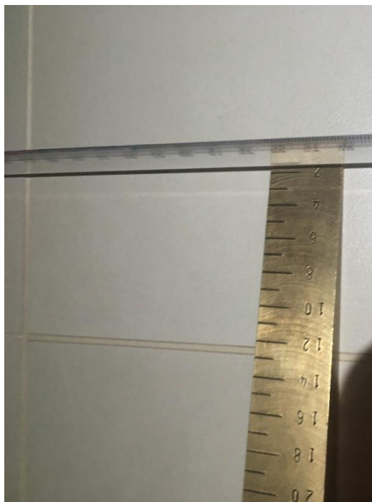
Obr. 25 – Detail měření přesahů v koupelně v bytě 1.02
