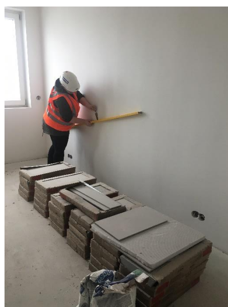
Obr. 19 – Měření v bytě 1.05
