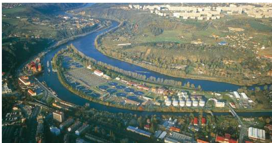
Obr. 3. – Ústřední čistírna odpadních vod v Praze [9]
