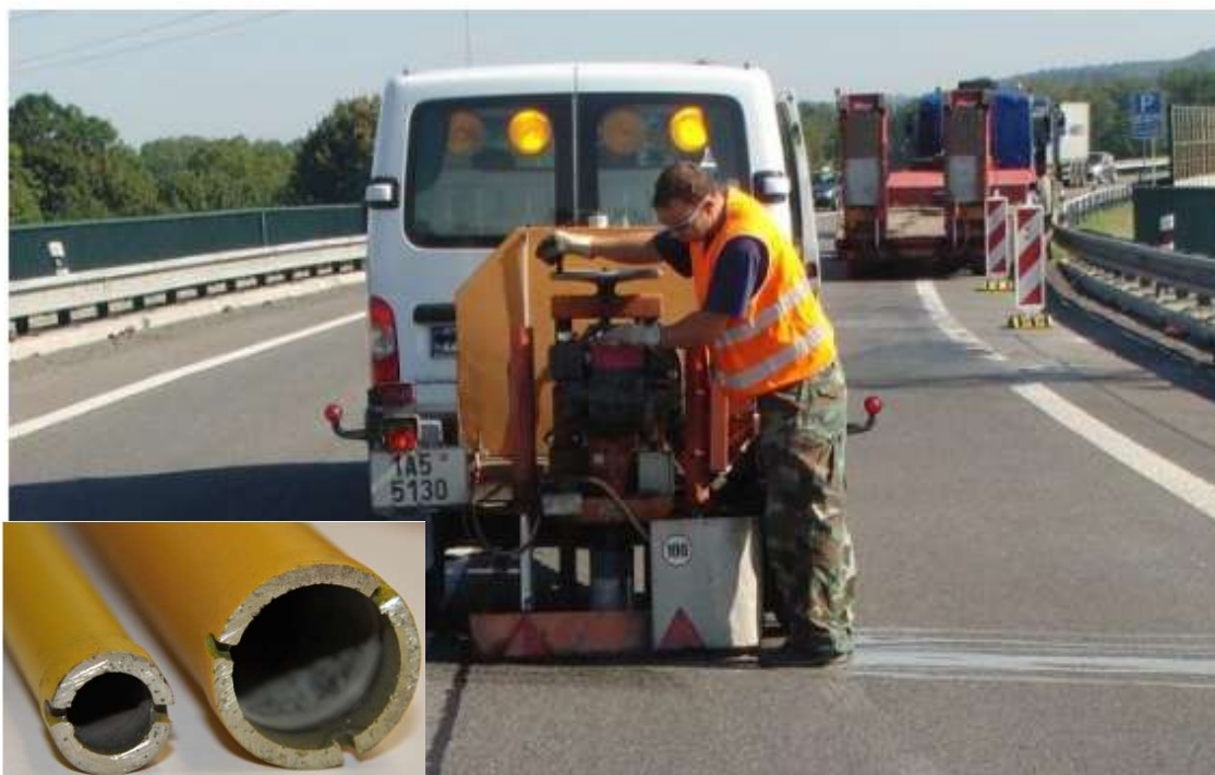
Obrázek 25 - Provedení jádrového vývrtu a ukázka diamantové korunky [26] [27]
