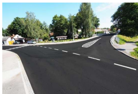
Obrázek 24 - Vozovka s asfaltovým krytem [23]
