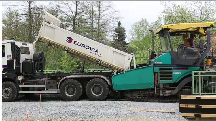
Obrázek 15 - Doprava asfaltové směsi s vyložením do finišeru [21]
