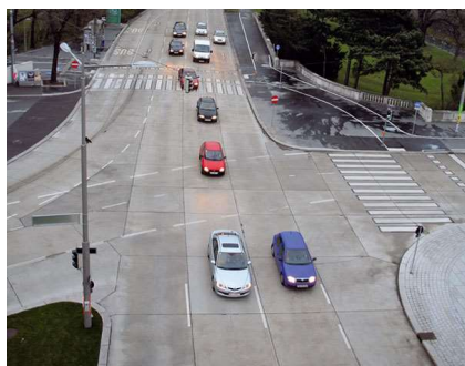
Obrázek 23 - Vozovka z cementobetonového krytu [22]
