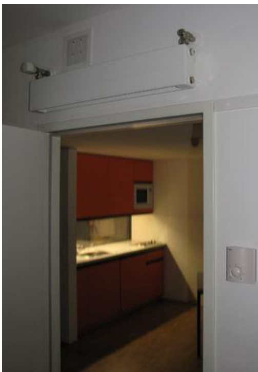
Obr.7 Otopné těleso pod větrací mřížkou [17]
