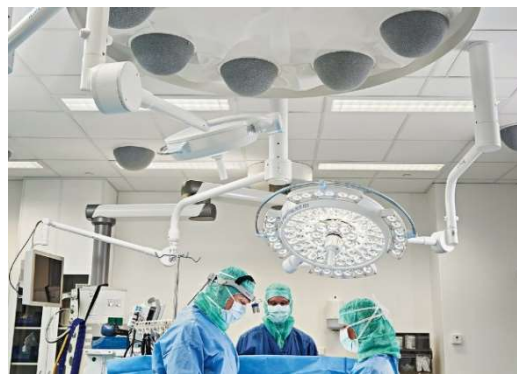
Obr. 9.2 TcAF systém na operačním sále [52]
