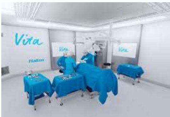
Obr. 9.1 Prstenec laminárního stropu kolem operačního stolu [50]
