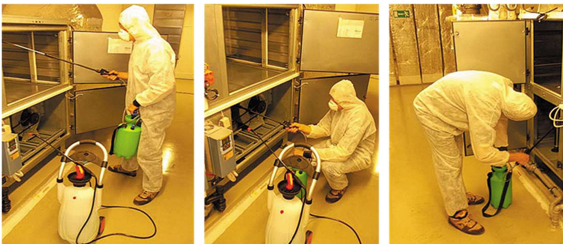
Obr. 8.3 Chemick e  ištění vzduchotechnick e jednotky [46]
