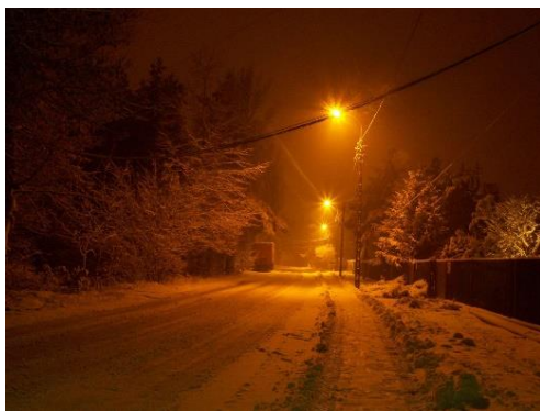
Obr. 15 Použití vysokotlaké sodíkové výbojky ve veřejném osvětlení (Převzato z [18])
