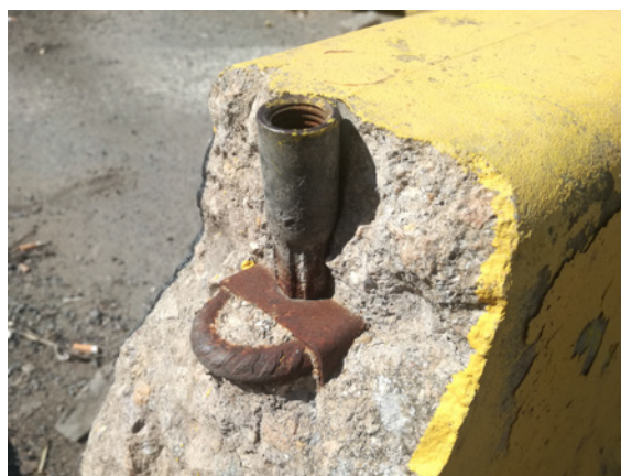
(d) Závitová kotva v betonovém svodidle [13]
