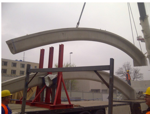
(c) Přeprava dílce na stavbě [14]
