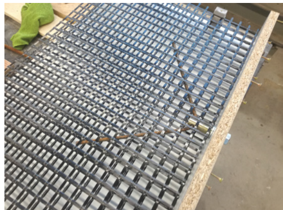
(b) Kotva s provlečenou výztuží před zabudováním do formy
