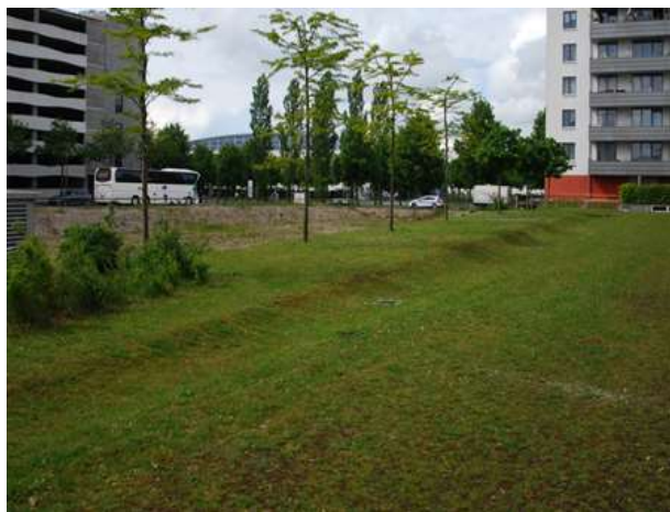
Obrázek 19_Vsakovací průleh [22]
