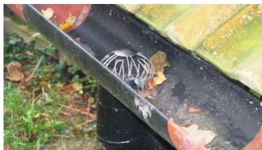
Obrázek 5_Lapač v hrdle svodu [10]
