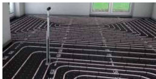
Obrázek 13: Podlahové teplovodní vytápění [26]
