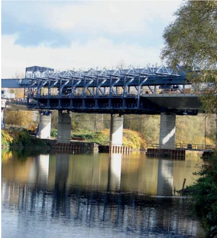
Obr. 5 Výsuvná skruž s horním nosným systémem 10
