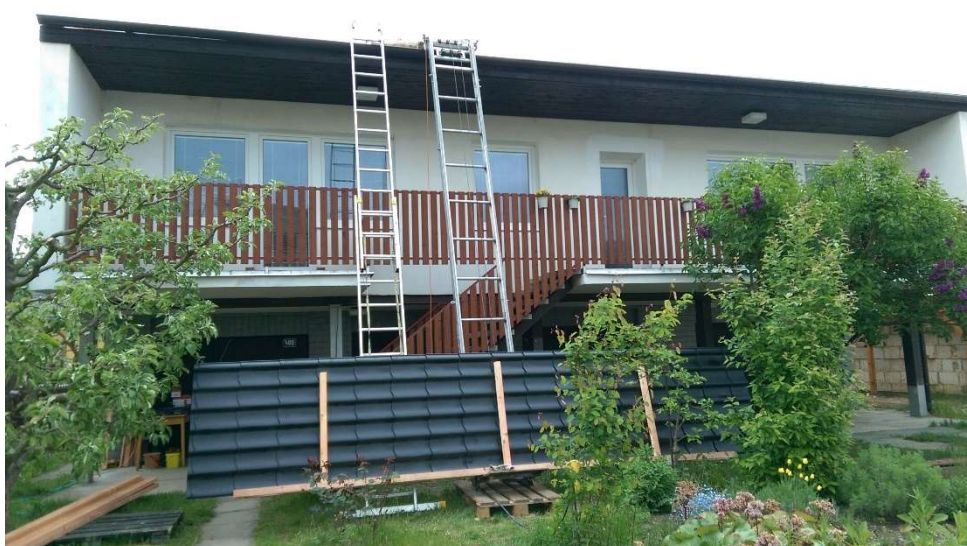
Obrázek 34, Doprava plechové profilované krytiny na střechu pomocí stavebního výtahu
