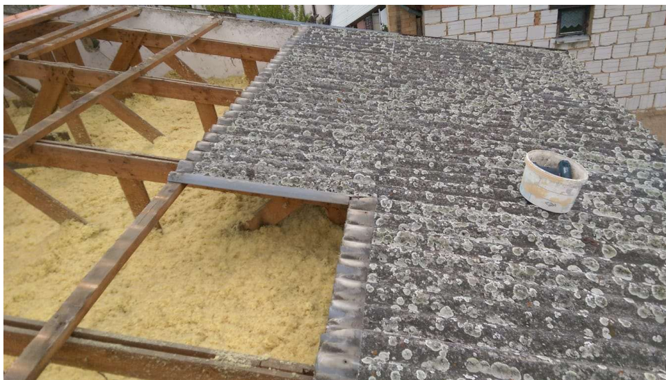
Obrázek 32, Demontáž stávající krytiny a pohled na krov
