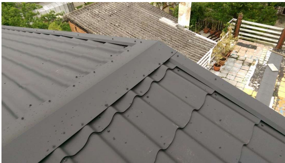
Obrázek 38, Detail hřebene a štítového lemování
