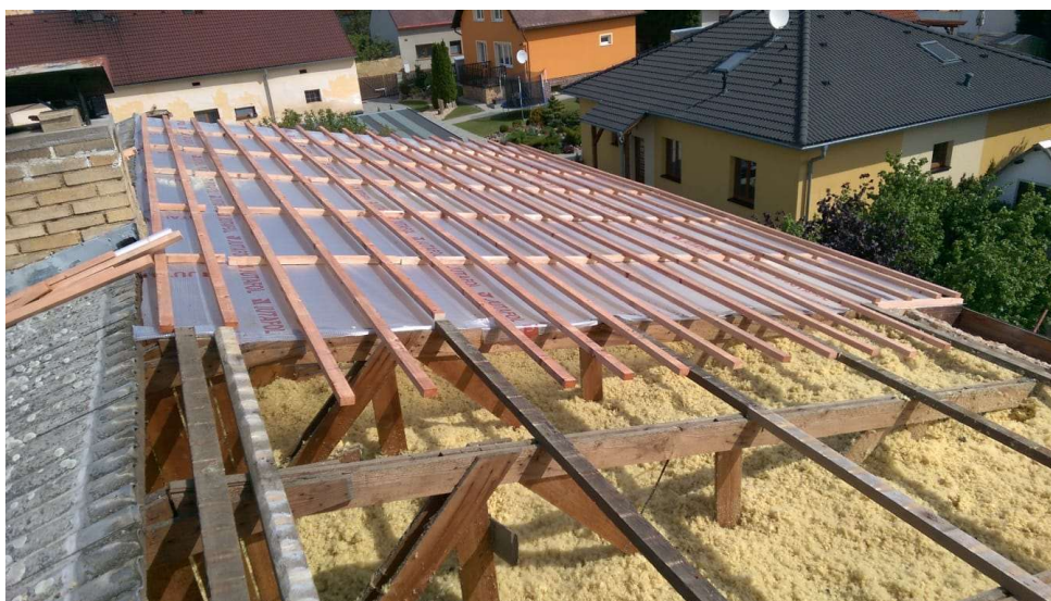
Obrázek 33, Difúzní folie a nové a staré laťování
