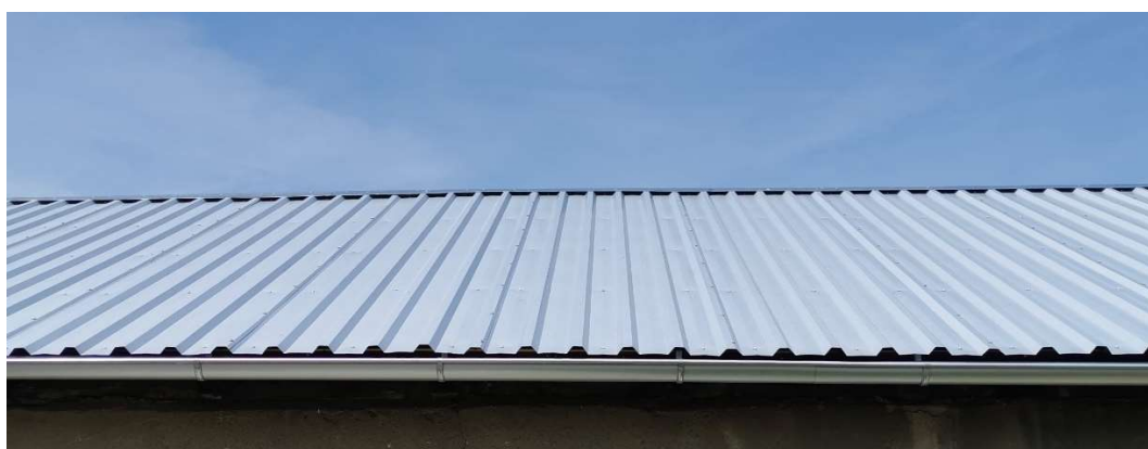
Obrázek 23, Trapézová plechová krytina
