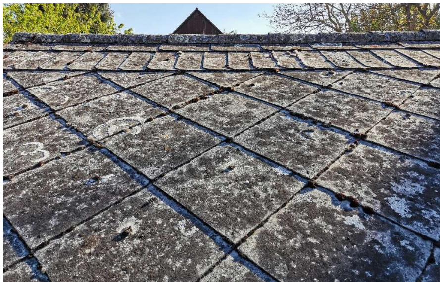
Obrázek 4, Pohled na Eternitovou krytinu (česká šablona) detail
