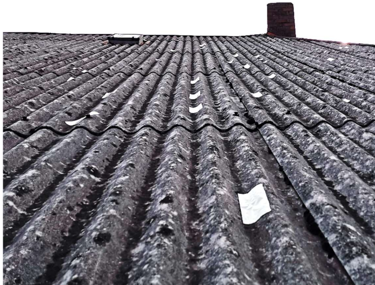
Obrázek 6, Pohled na velkoformátovou Eternitovou krytinu detail
