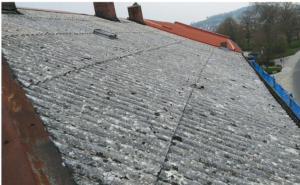
Obrázek 5, Pohled na velkoformátovou Eternitovou krytinu
