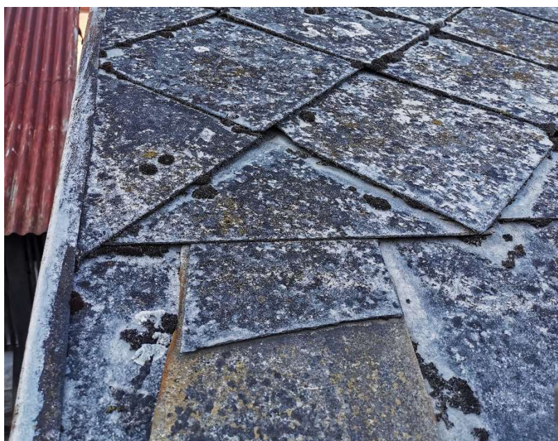
Obrázek 12, Rozpadající se šablony
