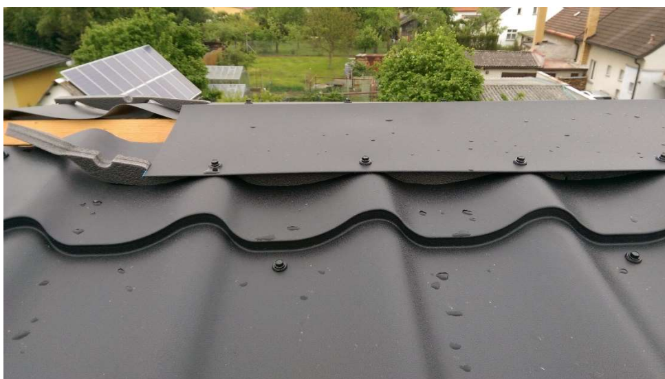
Obrázek 37, Detail provětrávaného hřebene
