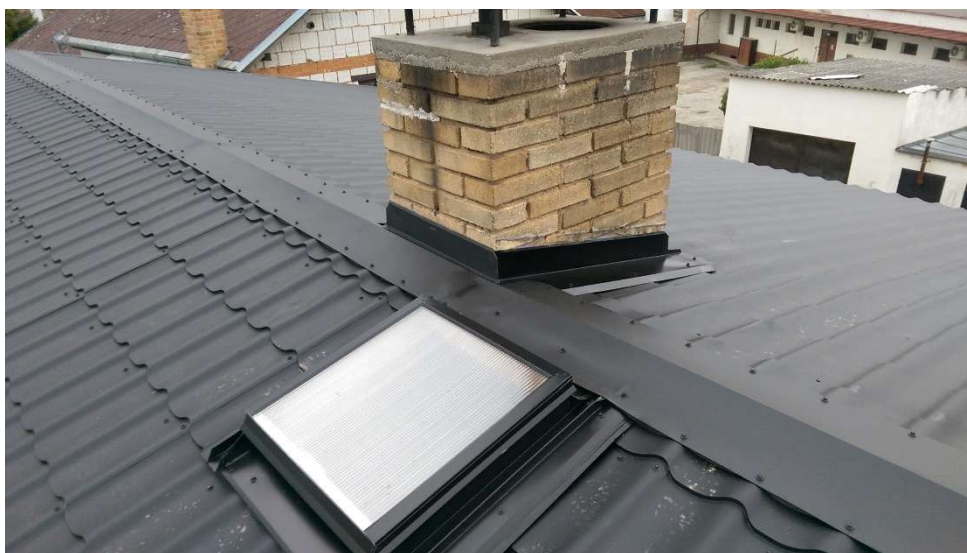
Obrázek 39, Oplechování komína a střešní výlez
