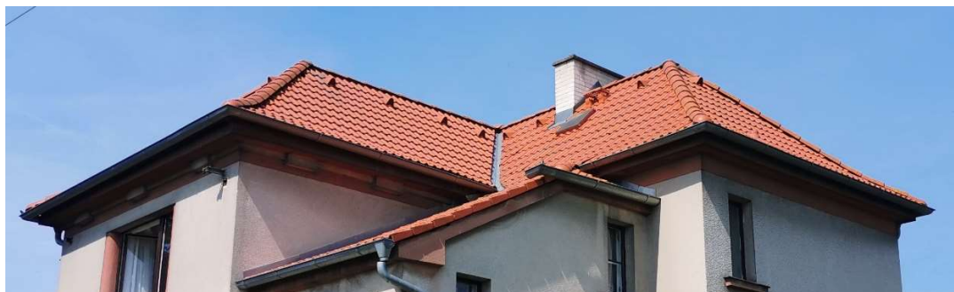
Obrázek 17, Betonová střešní krytina
