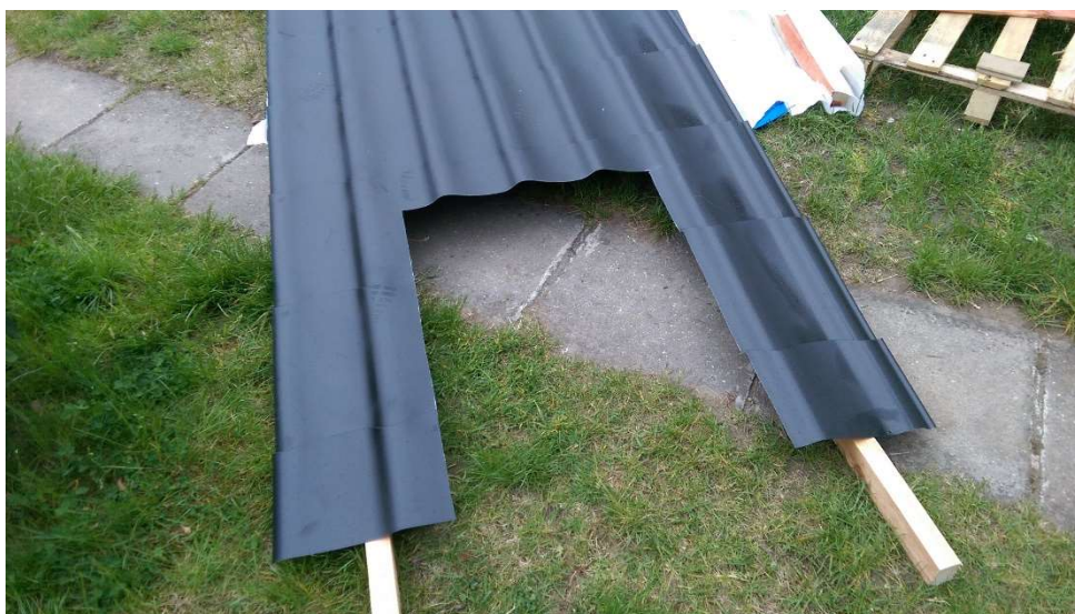
Obrázek 36, Příprava otvoru pro komín
