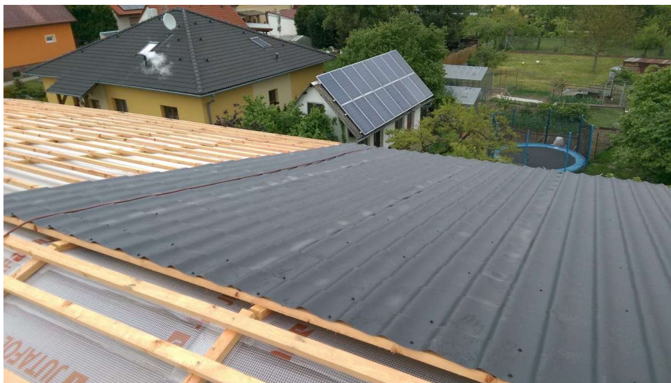
Obrázek 35, Montáž nové střešní krytiny
