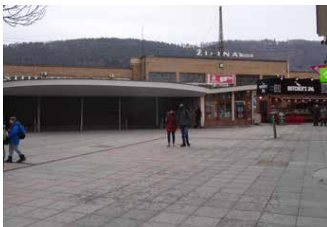
nehodne užitá veľkoformátová dlažba na Národnej ulici
