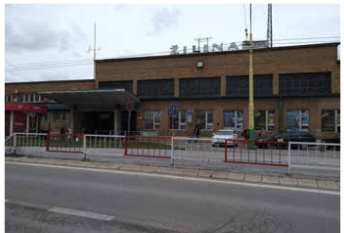
hlavný vstup a vyvýšená centrálna hala
