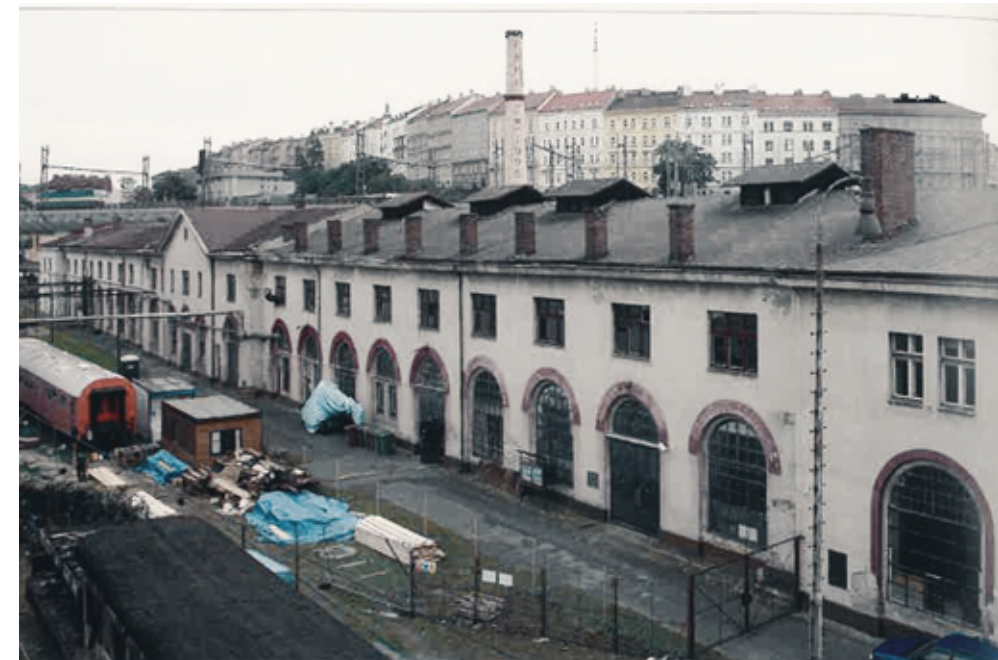
OBJEKT STROJNÍCH DÍLEN pohled na hlavní severní průčelí
