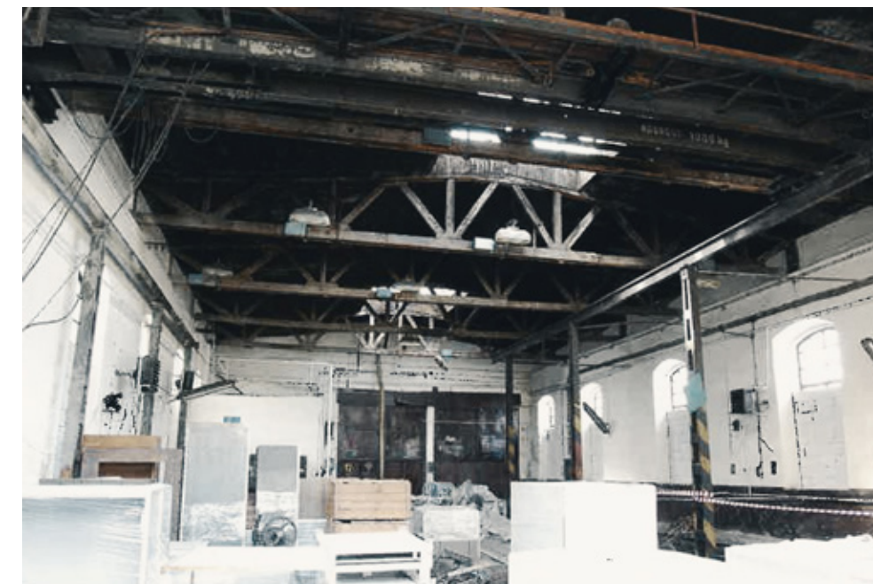
OBJEKT LAKOVNY pohled do vozovny
