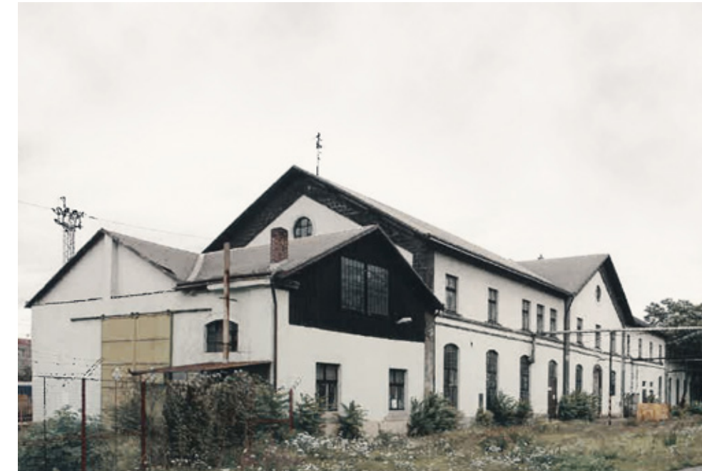
OBJEKT LAKOVNY pohled na jižní průčelí
