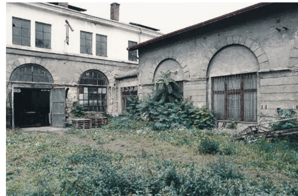
OBJEKT STROJNÍCH DÍLEN část jižního průčelí (vlevo) a objekt bucharu (vpravo)
