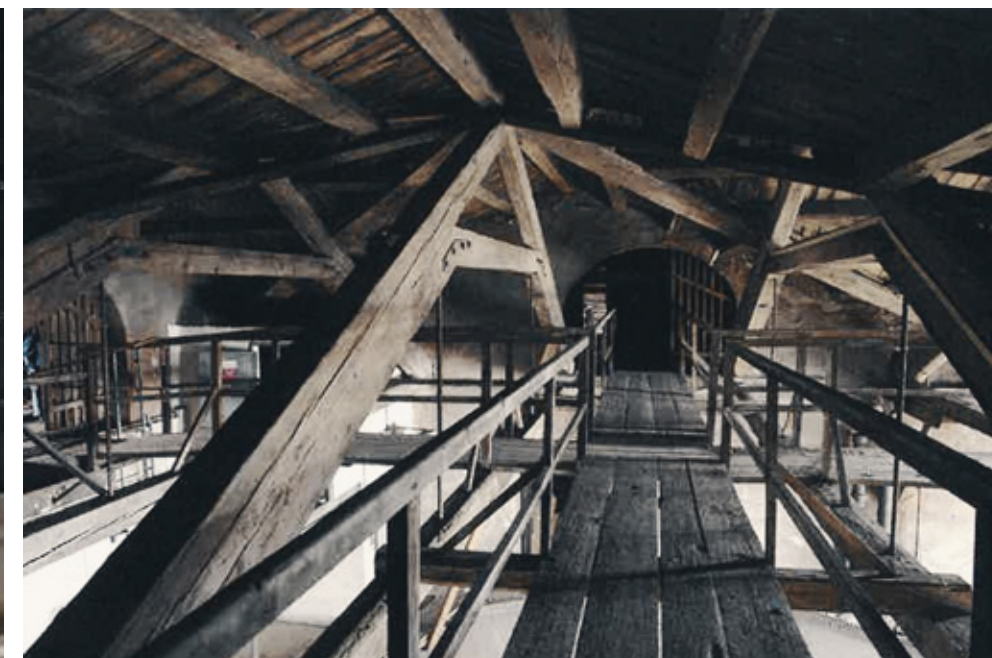
OBJEKT STROJNÍCH DÍLEN krov nad bývalým vodojemem
