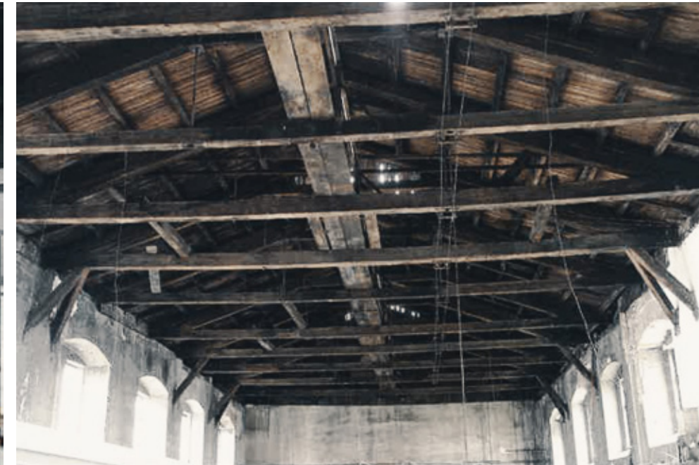
OBJEKT STROJNÍCH DÍLEN krov nad halovým prostorem v západním křídle
