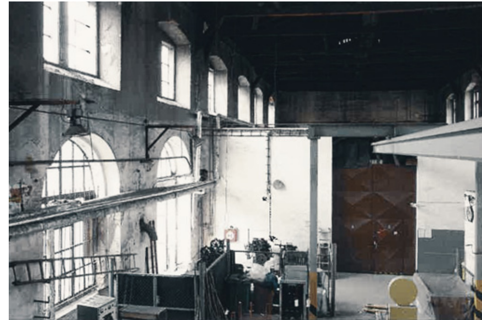
OBJEKT STROJNÍCH DÍLEN halový prostor v západním křídle
