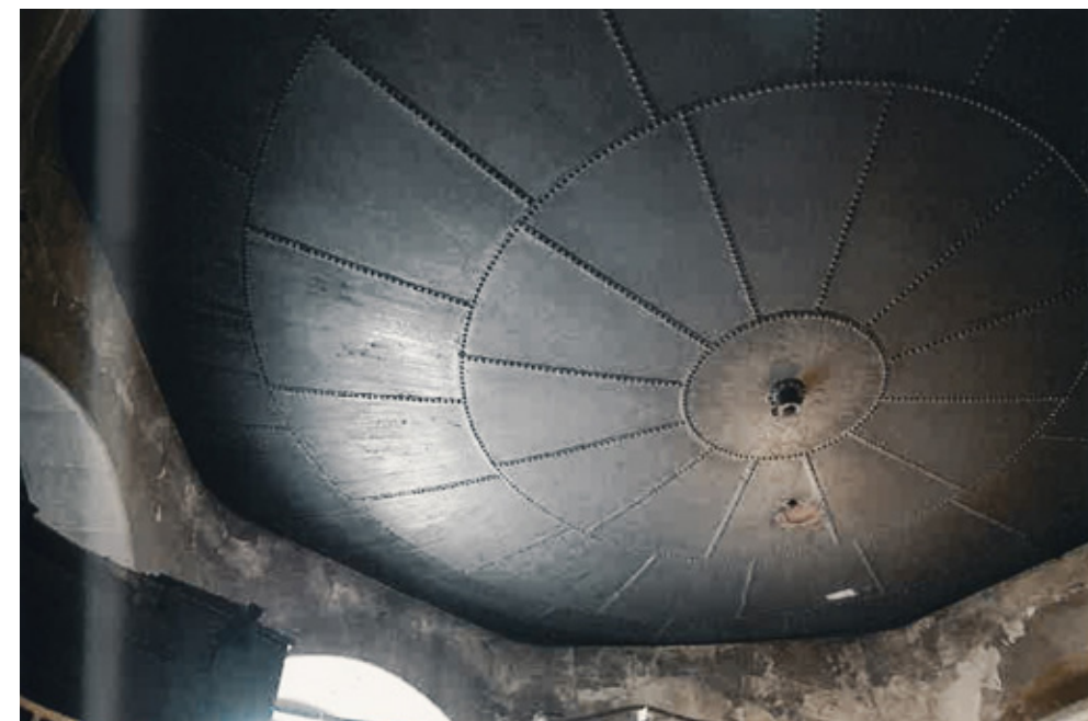
OBJEKT STROJNÍCH DÍLEN dno bývalého vodojemu
