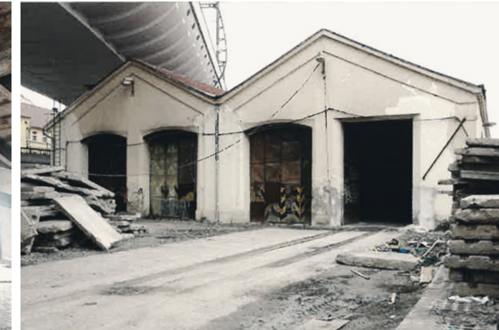
OBJEKT LOKOMOTIVNÍ REMÍZY pohled na východní průčelí
