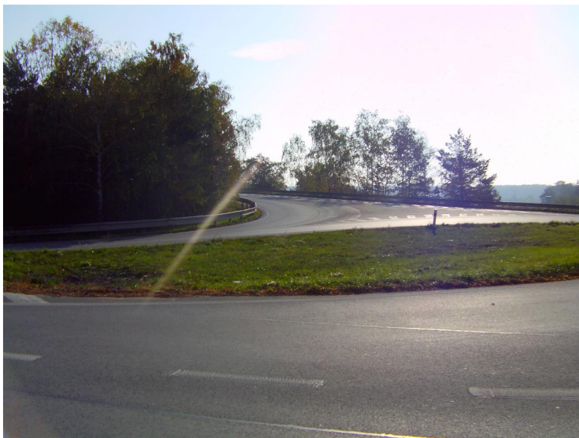
Obrázek 6: Pohled do křižovatky směrem k mostu, dělící ostrov
