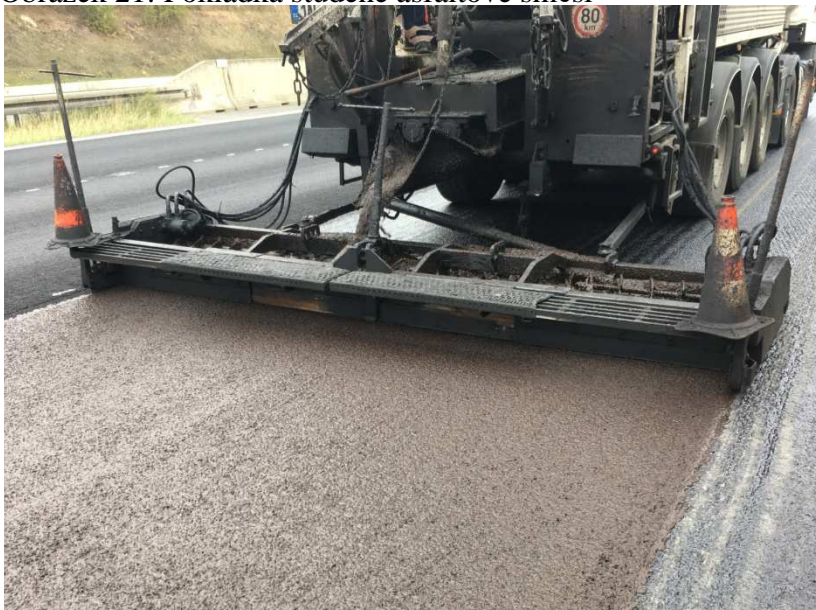
Obrázek 21: Pokládka studené asfaltové směsi
