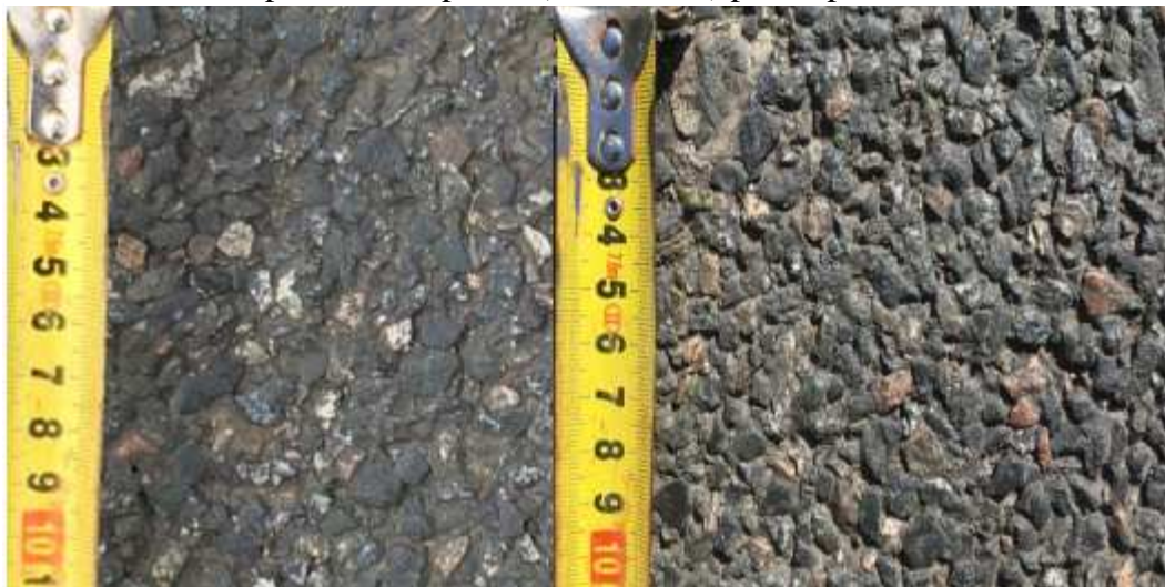
Obrázek 7: Detail povrchu Viaphone (BBTM NH) před a po čištění
