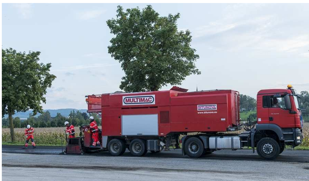
Obrázek 22: Pokládka mikrokoberce typu MULTIMAC®
