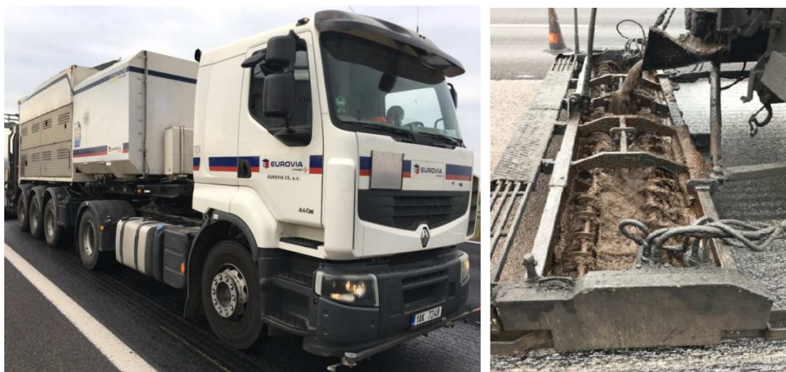
Obrázek 19: Míchací zařízení a kladeční rám
