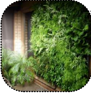
VEGETAČNÍ STĚNA S HYDROPONII
