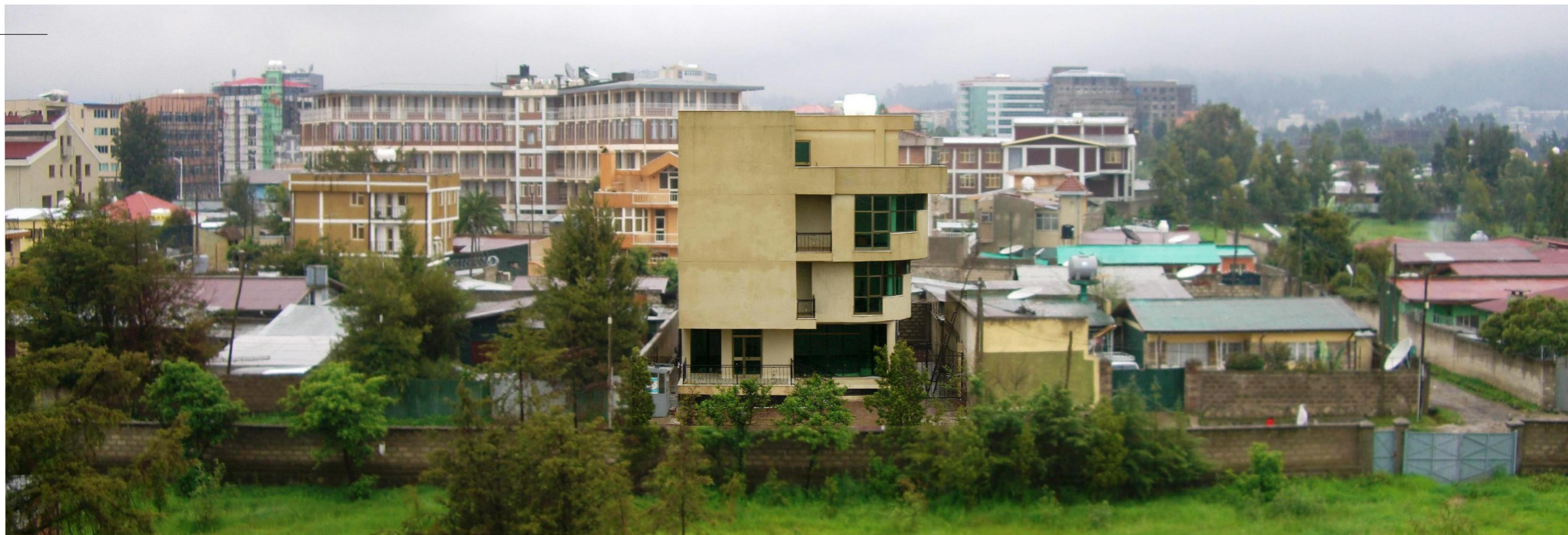
Pohled na budovu školy a pozemek z jihu.
