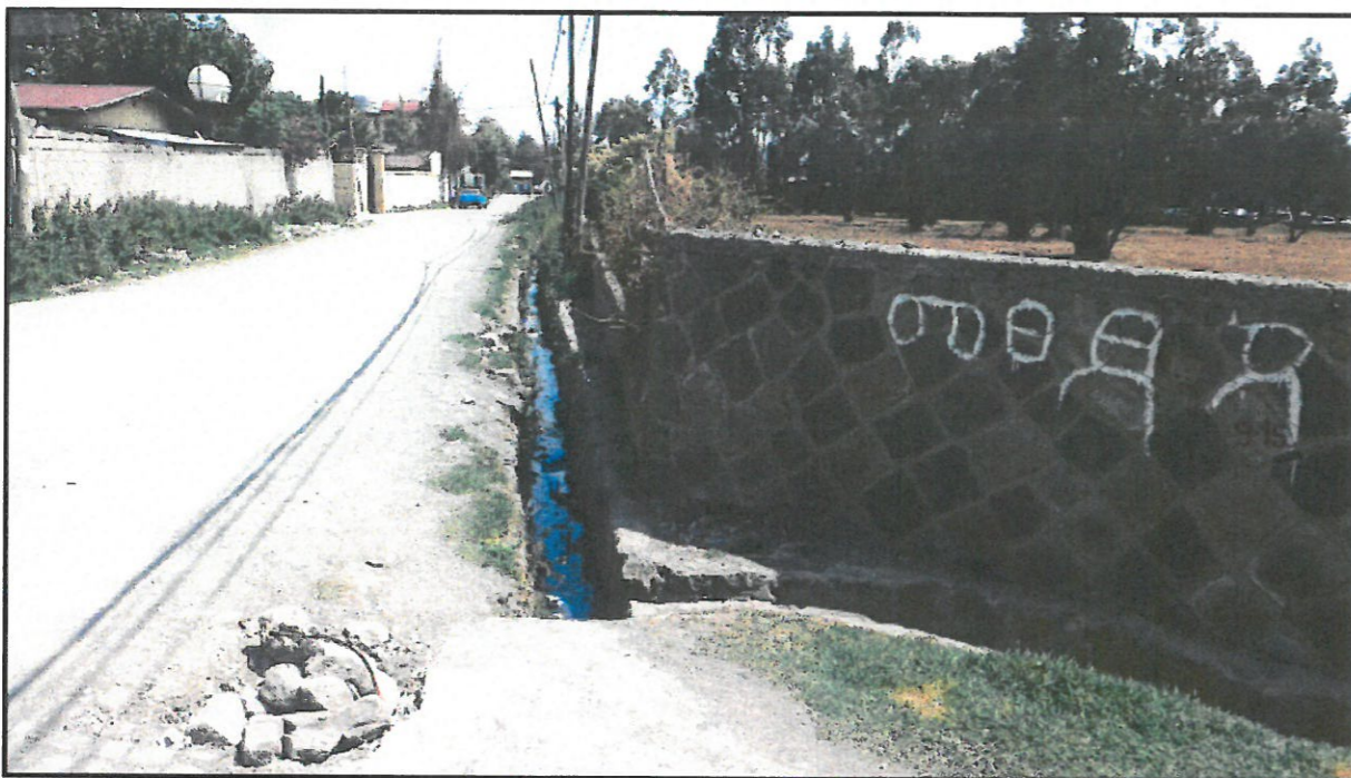
Obr. 1: Zpevněná povrchová kanalizace podél východní hranice pozemku.
