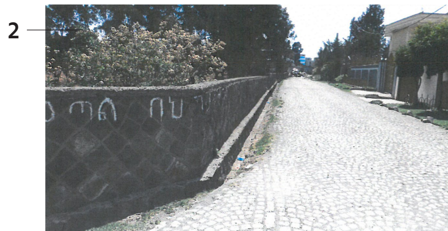
2 Zpevněná povrchová kanalizace podél východní hranice pozemku.
