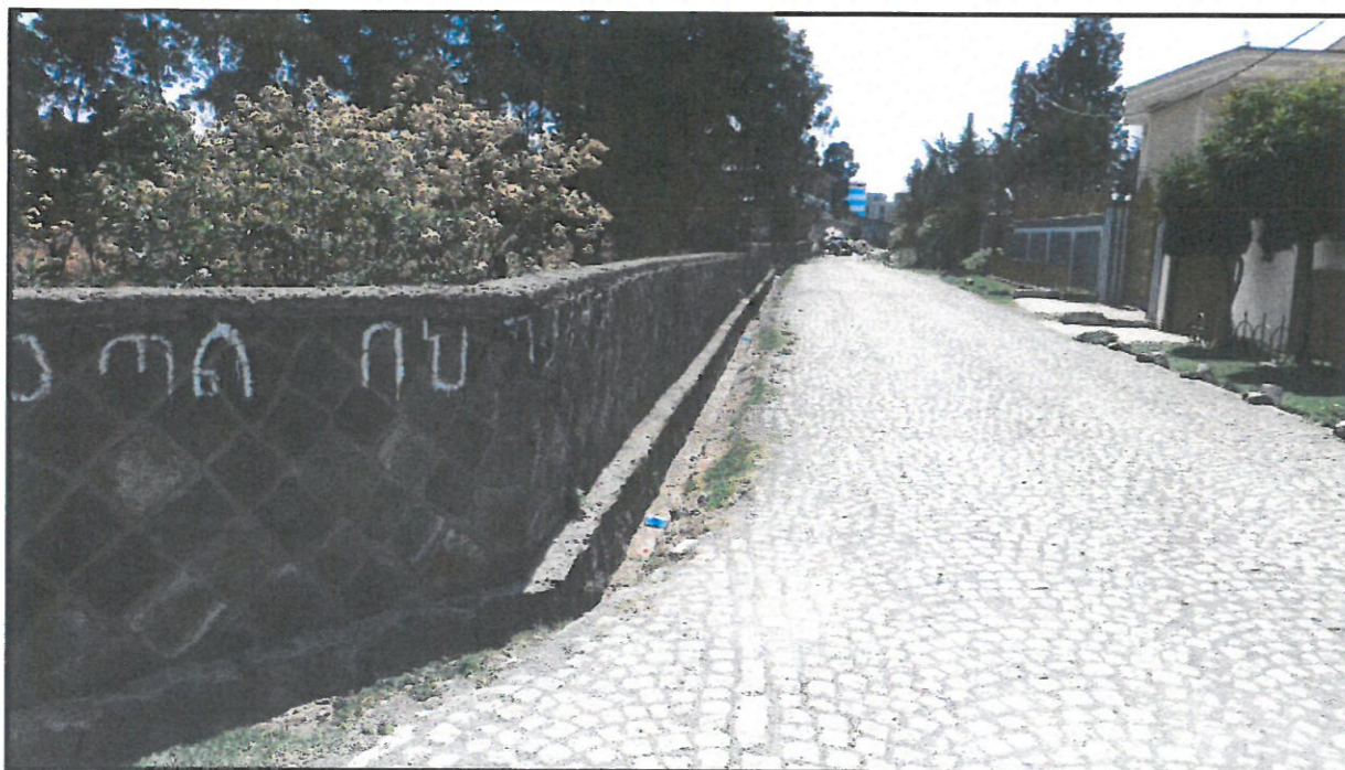
Obr. 2: Zpevněná povrchová kanalizace podél severní hranice pozemku.
