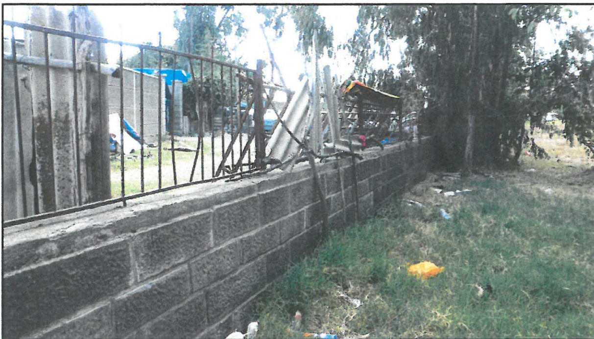
Obr. 5: Střední část jižní hranice pozemku hraničící se slepým koutem okupovaným protilehlým autoservisem.
