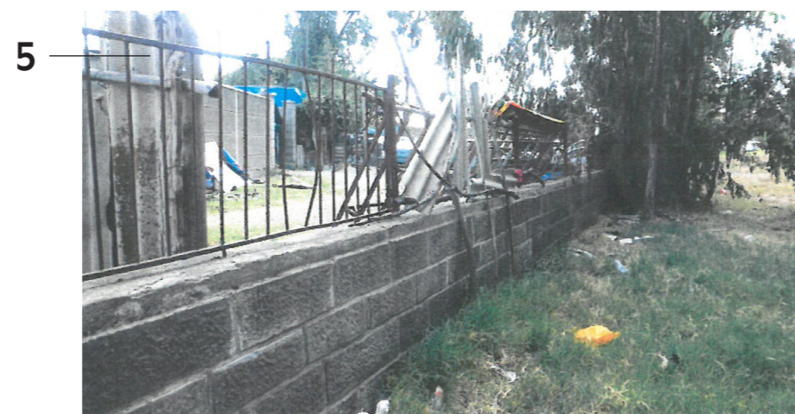
5 Hranice pozemku, za níž je vidět slepá část ulice se záborem místního autoservisu.
