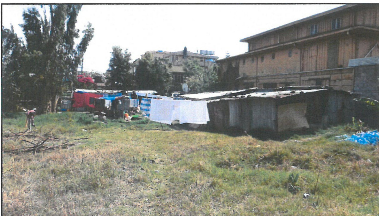
Obr. 6: Komplex budov obývaný rodinou místního hlídače a k pozemku přilehlá budova sousední školy v JZ rohu pozemku.
