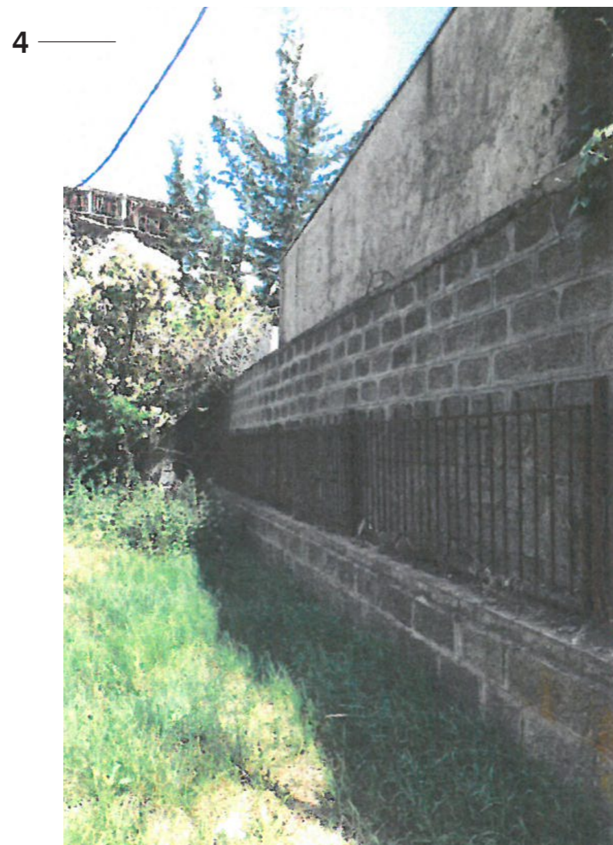
4 Východní část jižní hranice pozemku se zdmi sousedních rezidenčních budov bez proluky.
