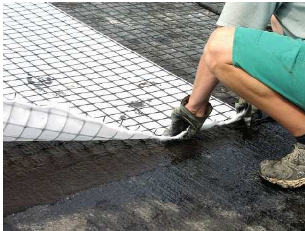
Obrázek 11 Pokládka geosyntetika [11]
