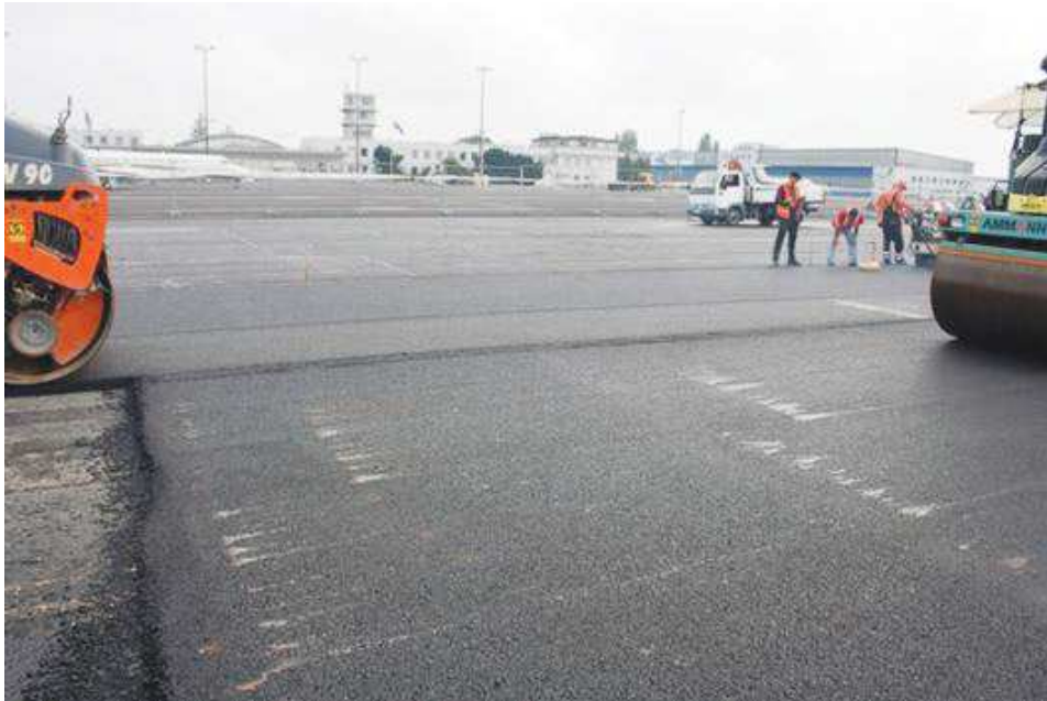
Obrázek 25 Pokládka nové směsi na Letišti Václava Havla [12]
