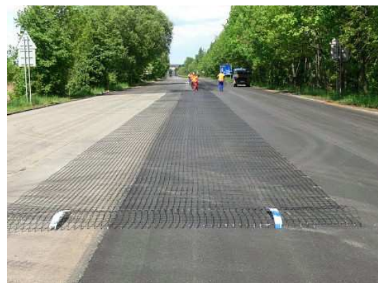
Obrázek 12 Připevnění geomříže pomocí hřebů a položená geomříž. [11]
