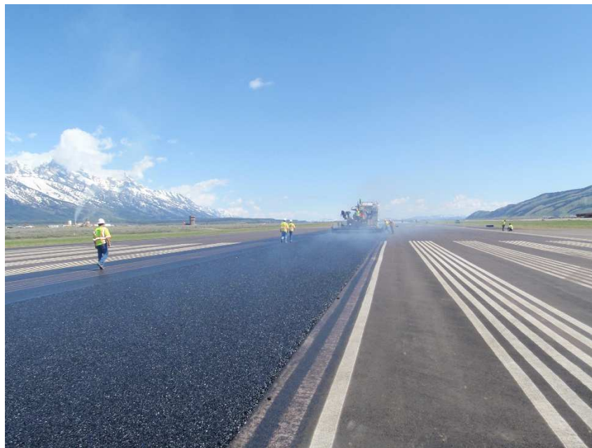
Obrázek 22 Pokládka ranveje 1/19 Jackson Hole Airport [12]
