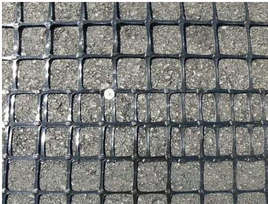
Obrázek 12 Připevnění geomříže pomocí hřebů a položená geomříž. [11]
