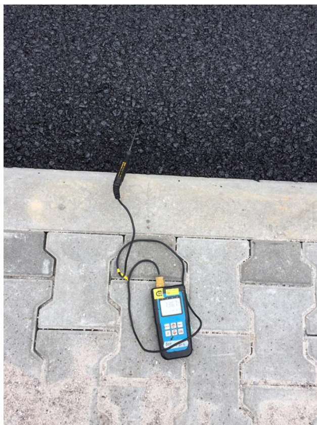
Obrázek 19: Speciální teploměr na měření teploty asfaltové úpravy.
