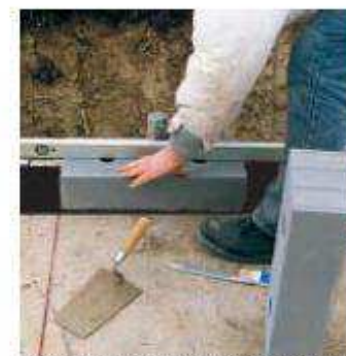
Beim Anlegen der Kimmsschicht werden die KS-ISO-Kimmsteine in Waags gelegt.
