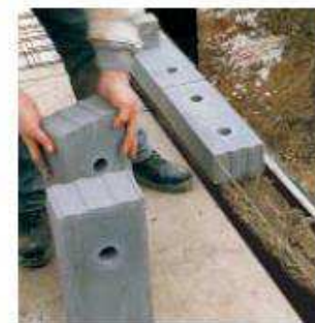
KS-ISO-Kimmsteine werden in Normalmörtel verlegt.
