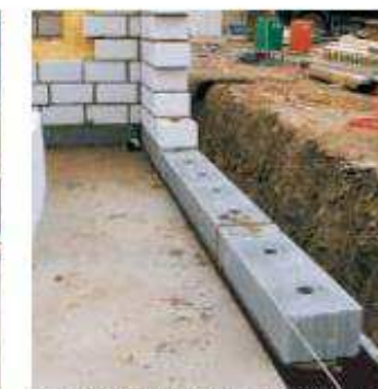
Rohstoffbedingt weisen KS-ISO-Kimmsteine eine graue Färbung auf. Eine Verwechslung mit anderen Kalksandsteinen ist dadurch ausgeschlossen.
