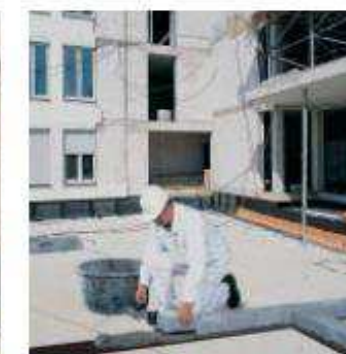
Die Stoßfugen bleiben dabei unvermörtelt.
