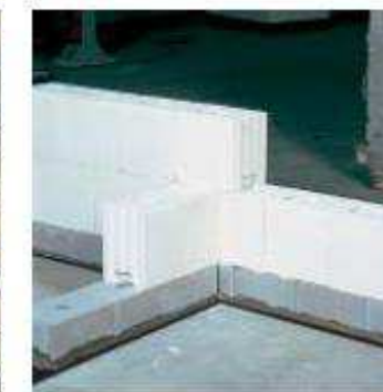
Der KS-ISO-Kimmstein wird zweckmäßigweise in Außen- und Innenwänden vermauert.
