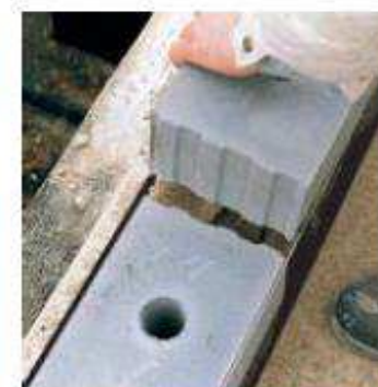
Durch das Nut-Feder-System können KS-ISO-Kimmsteine knirsch gestoßen werden.
