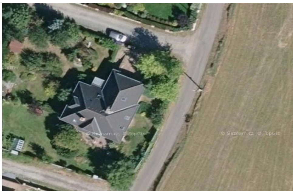
Obrázek 5 Pohled na střechu
